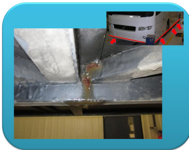
Figura 2.3 Soldadura mal aplicada bajo plataforma
