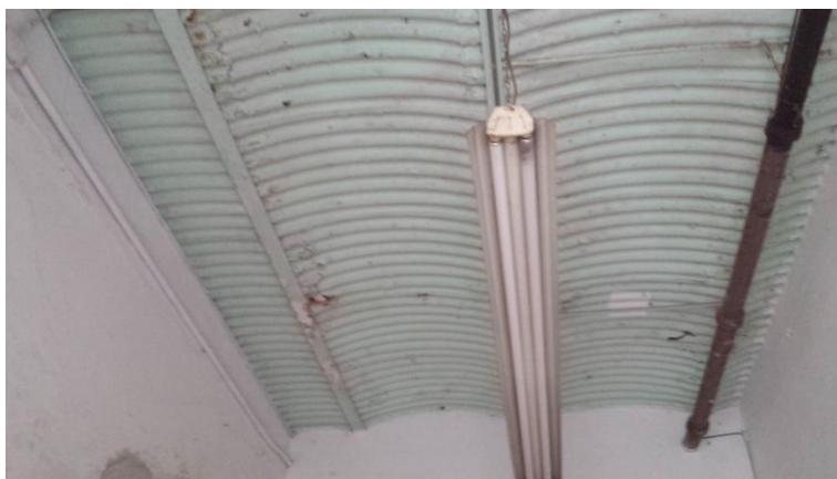
Figura 1. 17 Techo de Lámina de Zinc en San Jacinto
