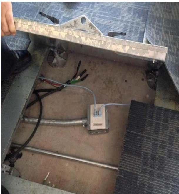
Imagen 3. Levantamiento de Piso Falso
