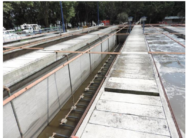
Fotografía 10. Muros de aireación
