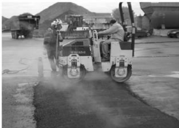
Figura 5.11. Compactación de la carpeta
