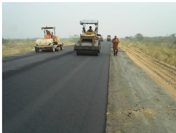
FIGURA 4.1- COMPACTACIÓN DE CARPETA ASFÁLTICA (CASAA)
