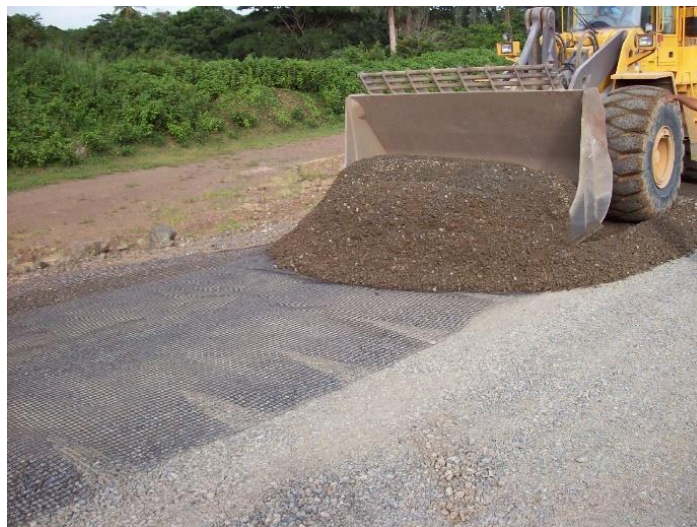
Figura 2.3.2- COLOCACIÓN DE GEOSINTÉTICO
