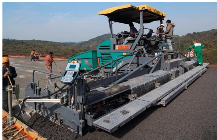
FIGURA 2.3.7- TENDIDO DE LA CARPETA ASFÁLTICA
