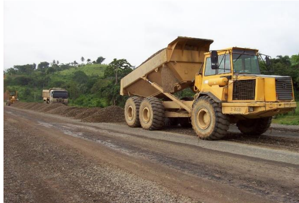
FIGURA 2.3.5- TENDIDO DE LA BASE
