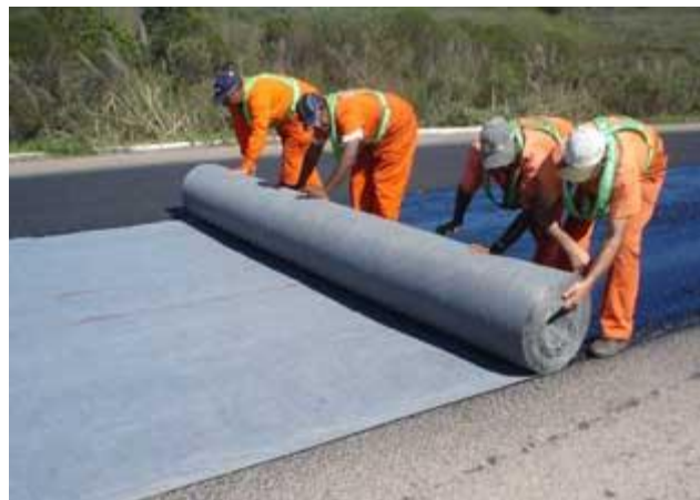
FIGURA 4.6.- COLOCACIÓN DE GEOTEXTIL
