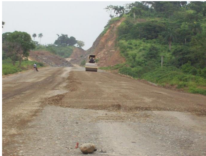
FIGURA 2.3.4- TENDIDO Y COMPACTACIÓN DE LA SUBBASE
