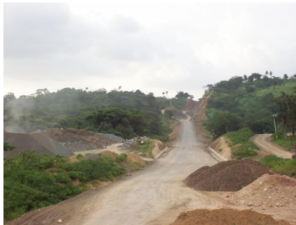
FIGURA 2.3.3.- TENDIDO DE GRAVA CEMENTADA SOBRE LA SUBRASANTE
