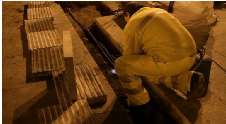
INSTALACIÓN DE DISPOSITIVOS IPAUMENT EN PAVIMENTO
