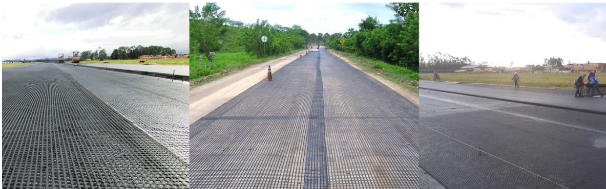
FIGURA 4.8.- INSTALACIÓN DEL GEOSINTÉTICO
