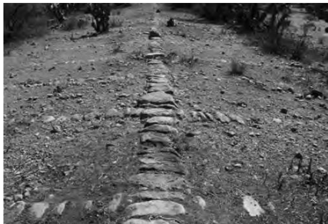
Figura 1.1. EMPEDRADO DEL CAMINO REAL. PUEDEN APRECIARSE LOS NIVELES Y EL BOMBEO.
