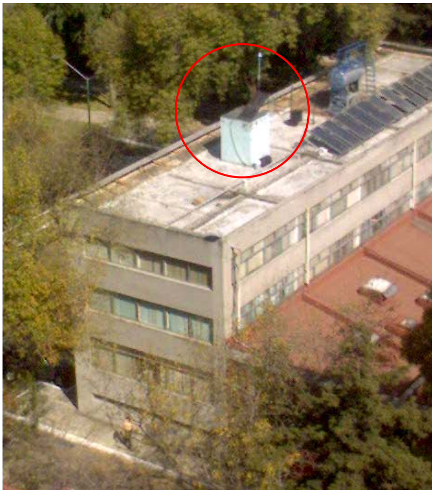
Fig. 10 Vista panorámica del enfriador nocturno en la azotea del edificio No. 2 del Instituto de Ingeniería de la UNAM
