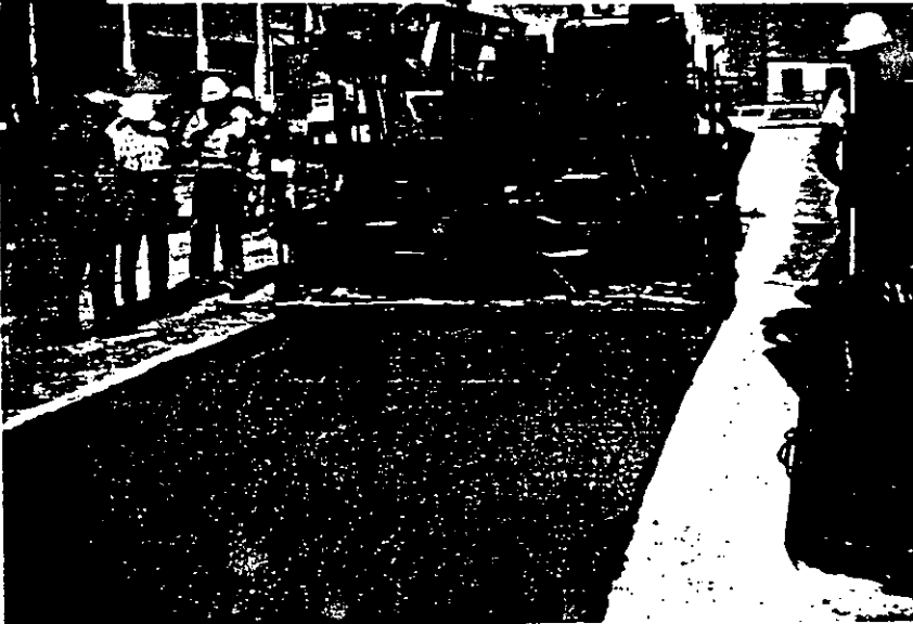
En esta figura puede verse un concreto de polímeros , es decir hecho de agregados y un monómero
