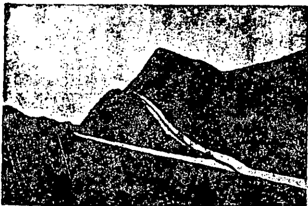
Una contracuneta bien impermeabilizada y complementada adecuadamente por escalonamiento en el corte.
