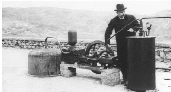
Figura 1.1 Primer motor usado para generación eléctrica con vapor geotérmico, y su inventor, Piero Ginori Conti [IGA, 2003]
