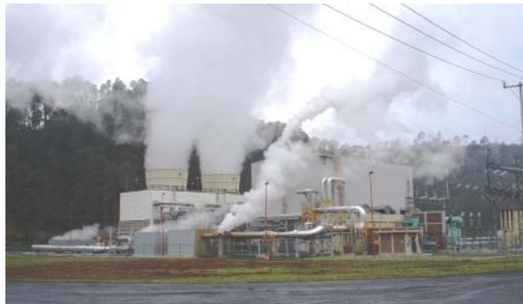
Figura 1.11 Central geotermoeléctrica Los Azufres [El autor]
