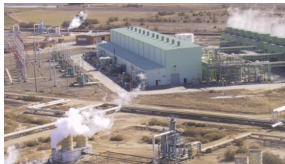
Figura 1.10 Central geotermoeléctrica Cerro Prieto [Comisión Federal de Electricidad, 2006]
