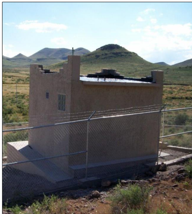
Figura 3.7 Pretil perimetral para el resguardo de las celdas solares y la antena
