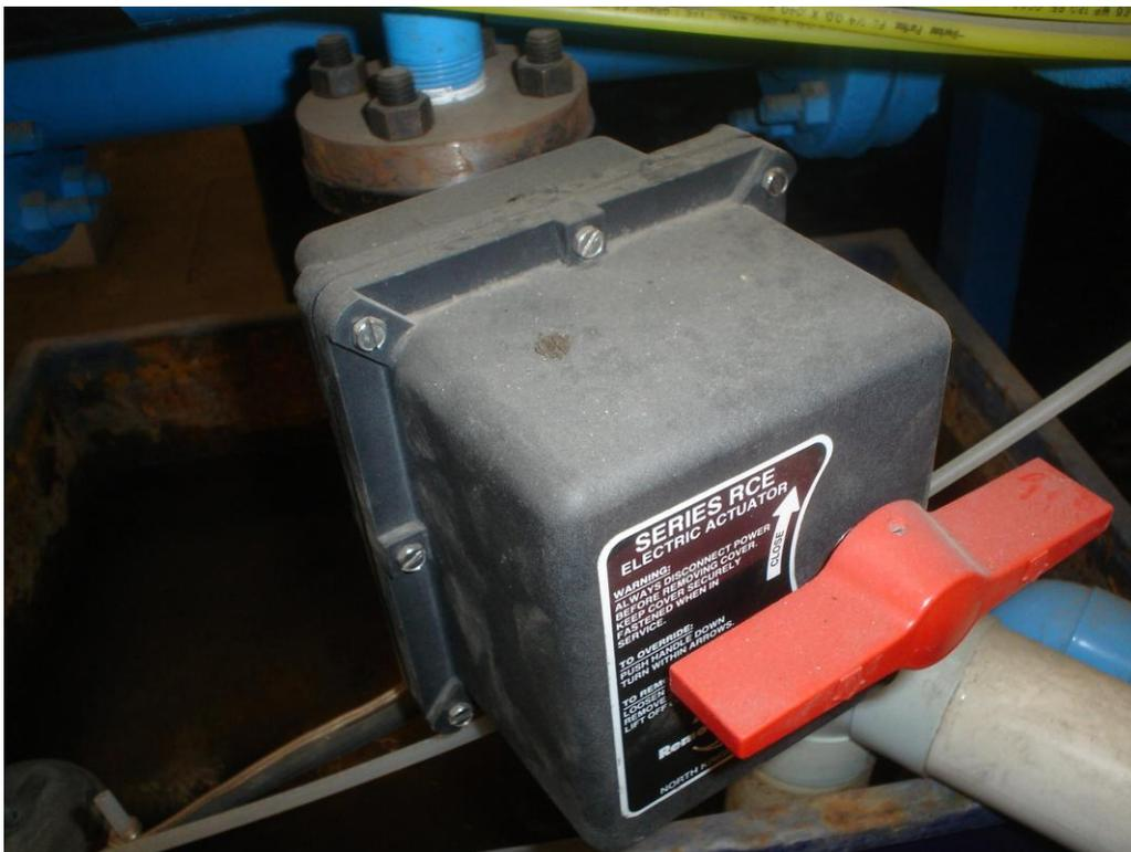
Fig. 2.6 Servo-válvula instalada a 68 m aguas abajo del tanque
