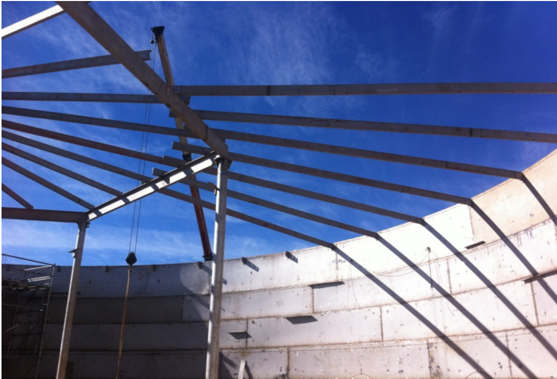
Figura 14. Armado de cuerpo y soportes de techo, vista interior.
