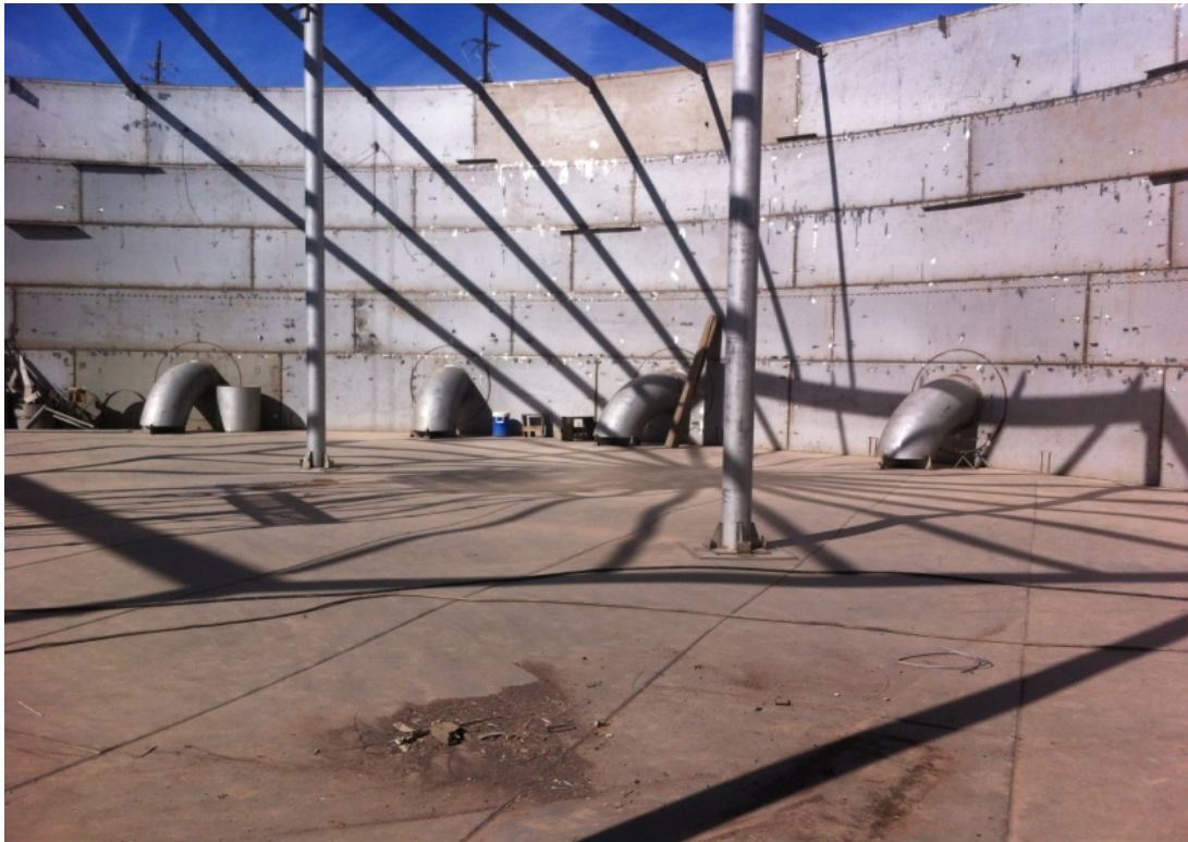
Figura 15. Armado de cuerpo y boquillas de 36" de diámetro, vista interior.
