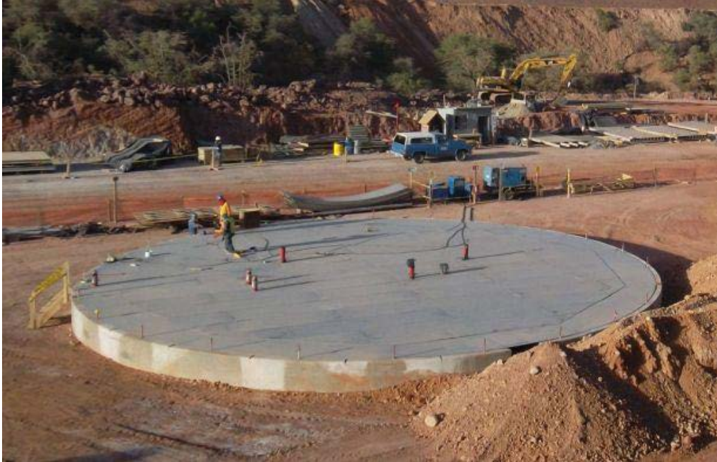
Figura 22. Ejemplo de cimentación y armado de fondo.
