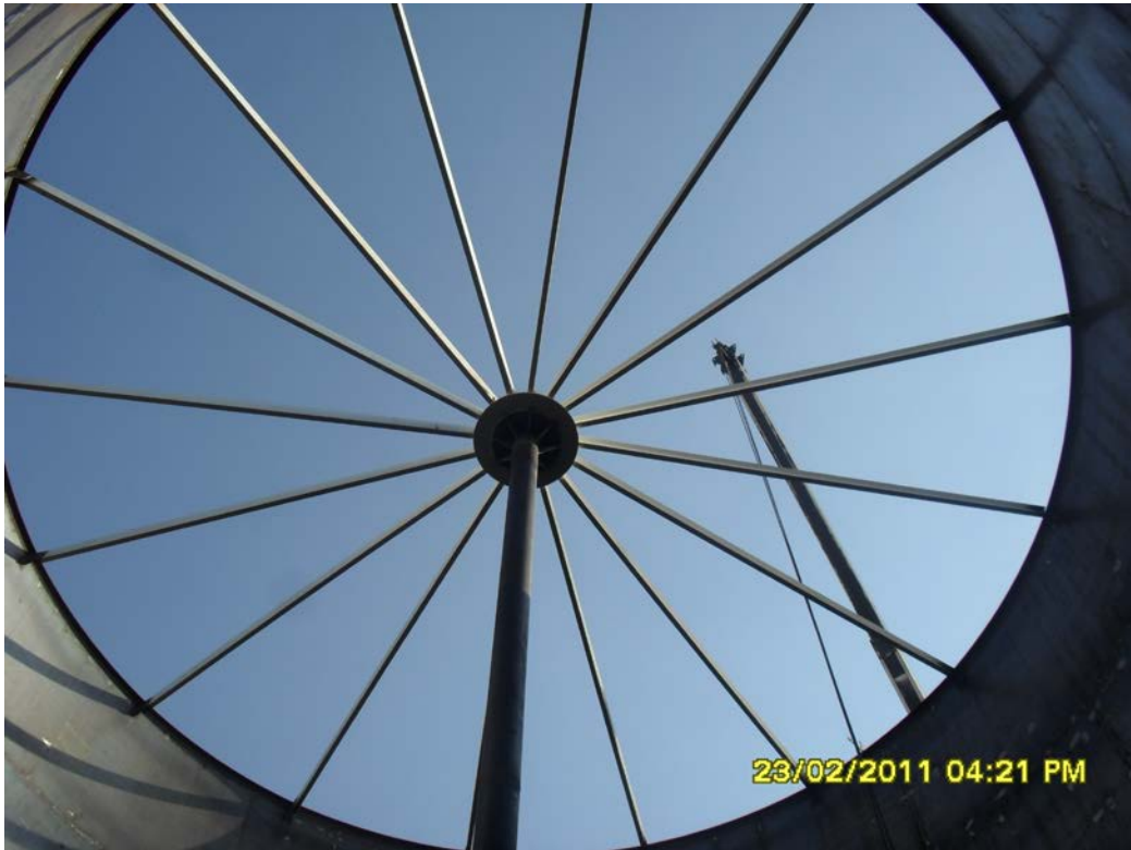
Figura 35. Soporte para techo soportado tipo cónico.
