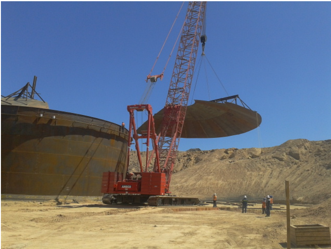
Figura 32. Ejemplo de montaje parcial de techo tipo cónico.
