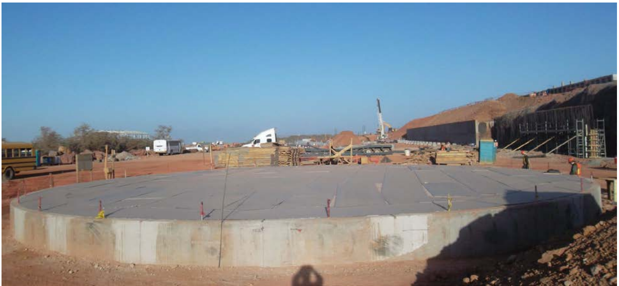
Figura 23. Ejemplo de cimentación y armado de fondo
