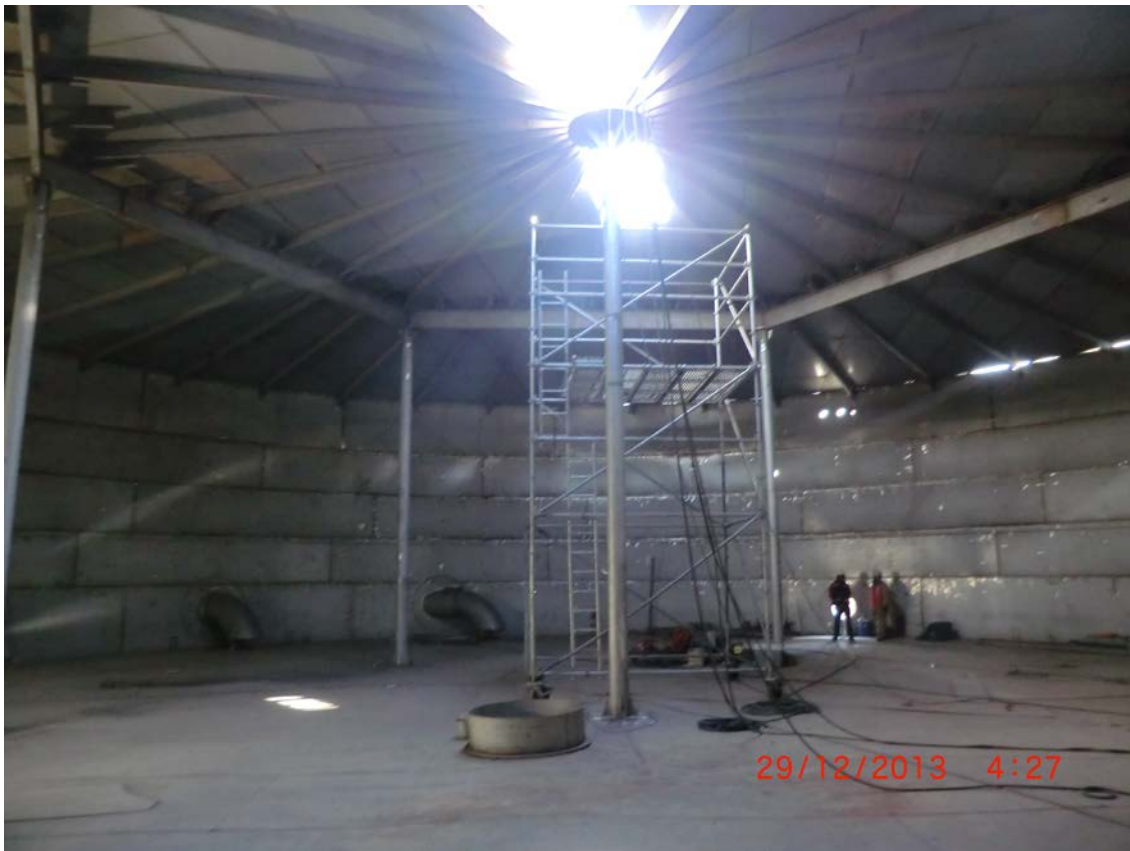
Figura 30. Vista interna de soporte para techo y techo parcialmente colocado.
