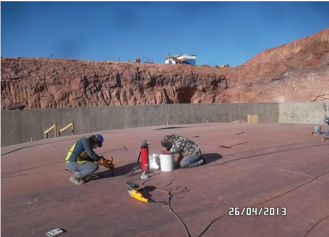
Figura 25. Ejemplo de cimentación y armado de fondo
