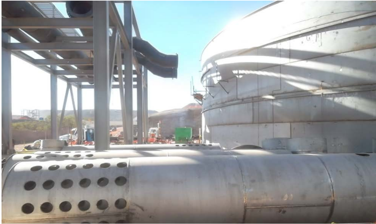
Figura 12. Armado de cuerpo, vista exterior.
