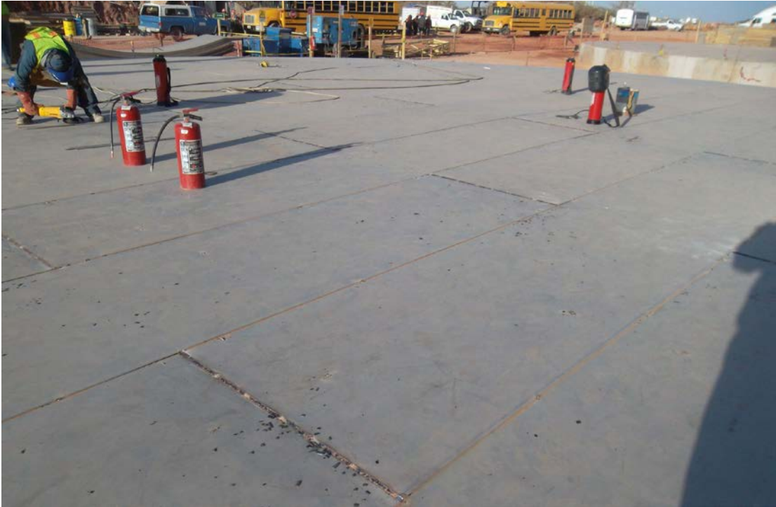
Figura 24. Ensamble de placa de fondo.
