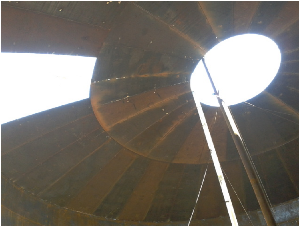
Figura 33. Ejemplo de montaje parcial de techo tipo cónico.
