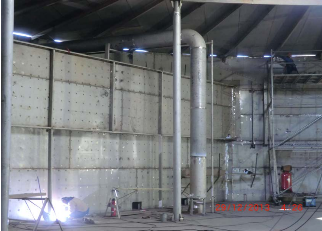
Figura 31. Vista interna de soportes, tubería y techo.
