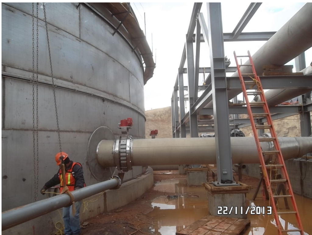
Figura 17. Instalación de boquillas de 36" de diámetro, vista exterior.
