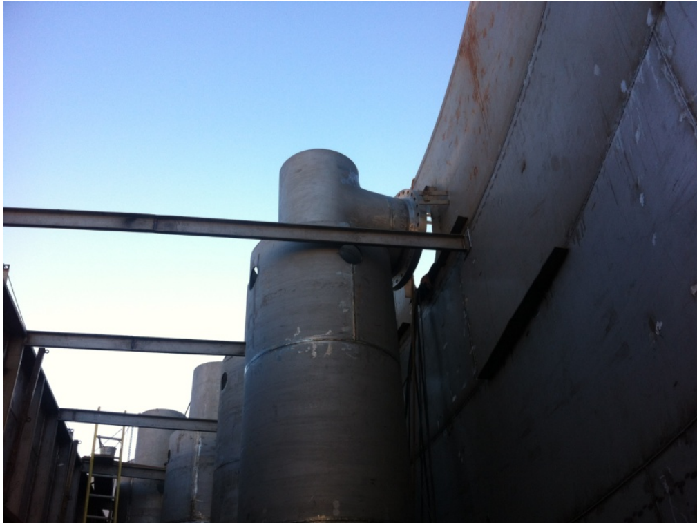
Figura 16. Instalación de boquillas de 36" de diámetro, vista interior.
