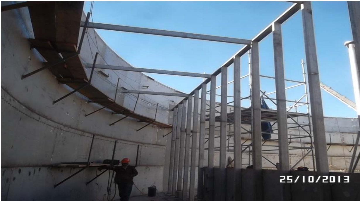
Figura 13. Armado de cuerpo, vista interior.
