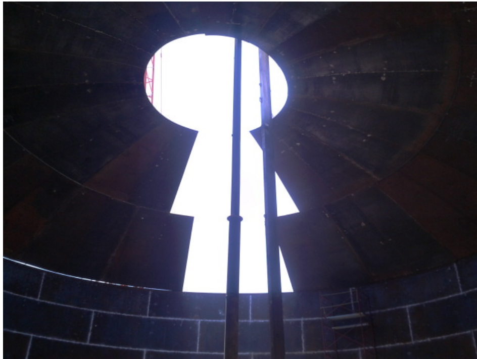
Figura 34. Ejemplo de montaje parcial de techo tipo cónico.
