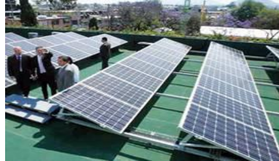
Figura 75. Edificio del Laboratorio de Alumbrado.
