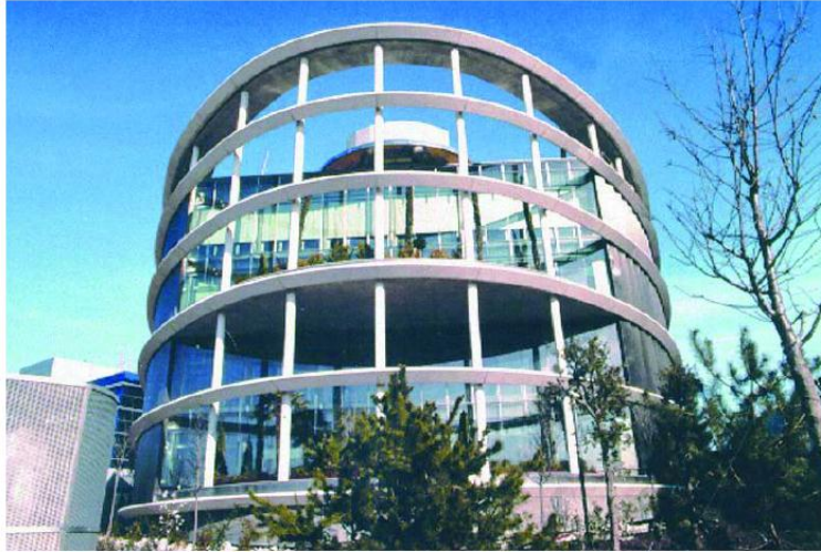
Figura 33. Edificio Bioclimático de Sanitas (Madrid).
