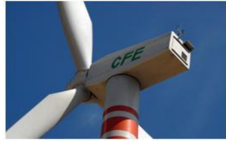
Figura 78. La Central La Venta II.
