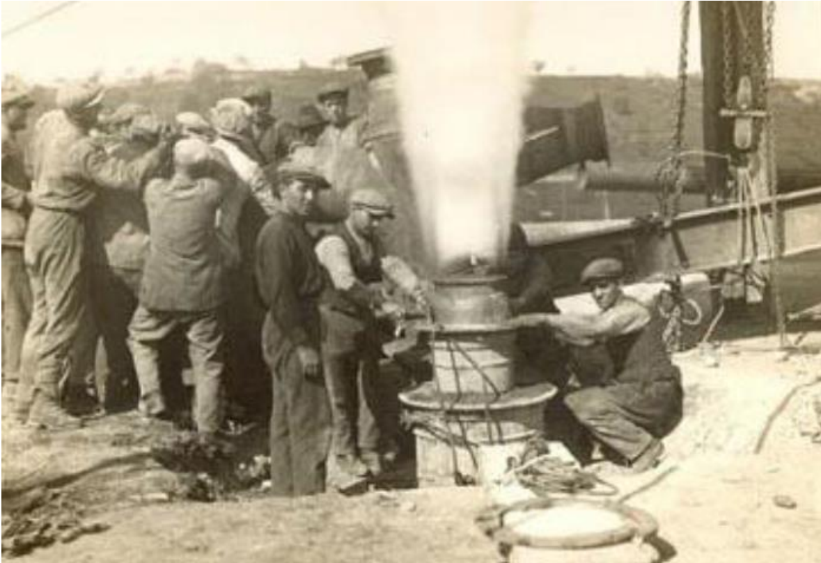
Figura 1.- Primer pozo geotérmico perforado en Larderello, Italia.
