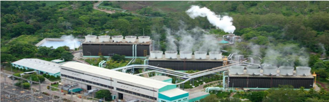
Figura 13.- Planta geotérmica en el Salvador
