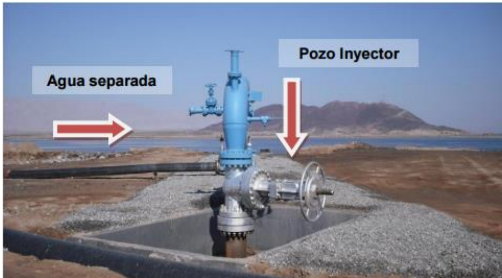
Figura 74.- Representación de agua separada (árbol de válvulas P.LATINA)
