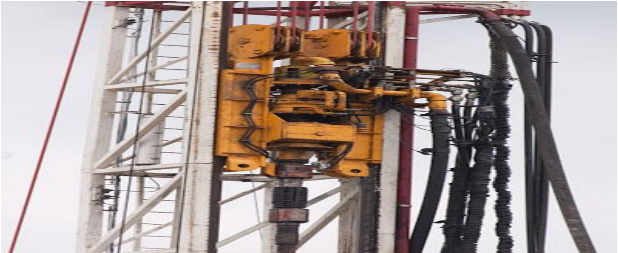
Figura 42.- Sistema Top Drive (Unión de Perforación Geotérmica Española)
