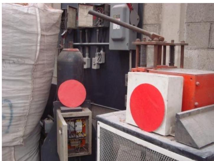
Fig. 55 Falta de señalización en terminales eléctricas.
