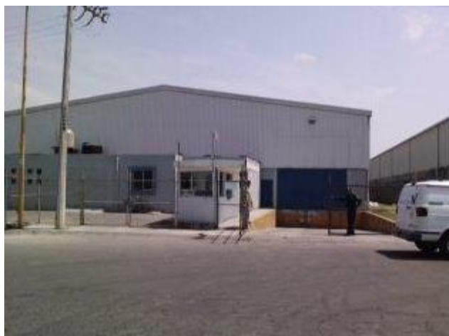
Fig. 41 3 Nave Industrial Parque Toluca 2000
