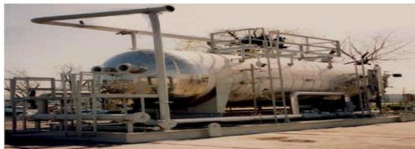
Figura 4.1 Instalación de una trampa para baches.
