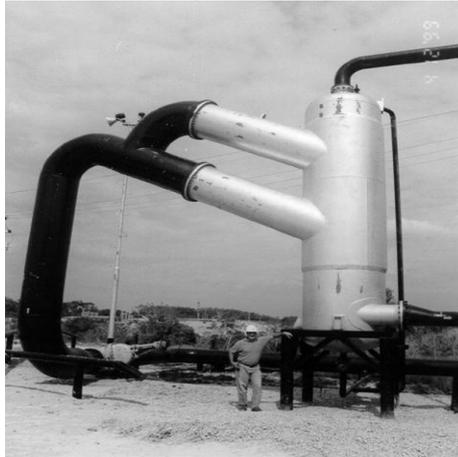
Figura 4.10 Sistema *GLCC* con *slug damper* instalado en Minas, Indonesia.
