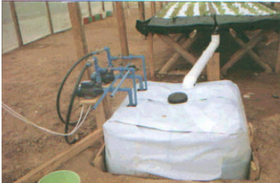
Fotografía 1: Estanque colector de plástico cubierto con polietileno coextrusado
