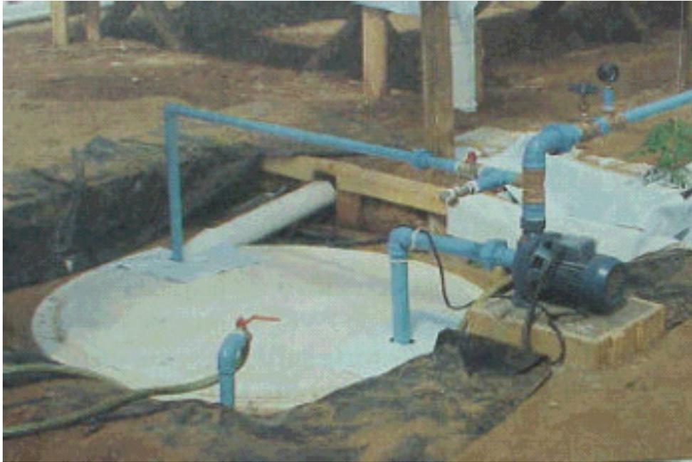
Fotografía 11: Bomba impulsora no sumergible instalada con el estanque colector
