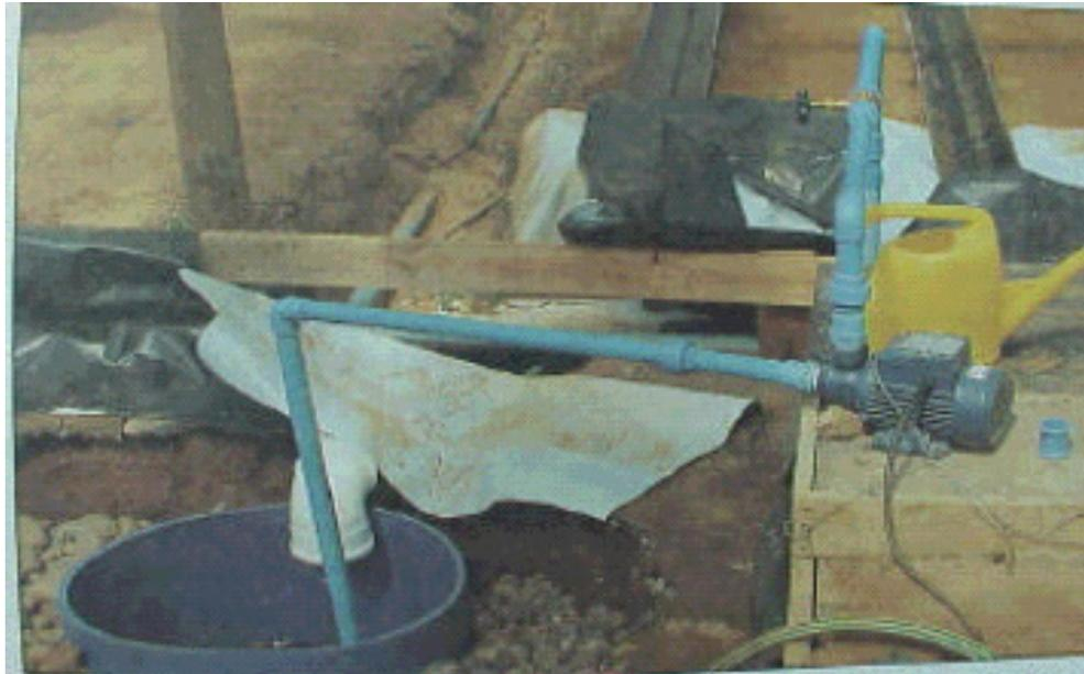
Fotografía 12: Bomba no sumergible con tubo de descarga de PVC
