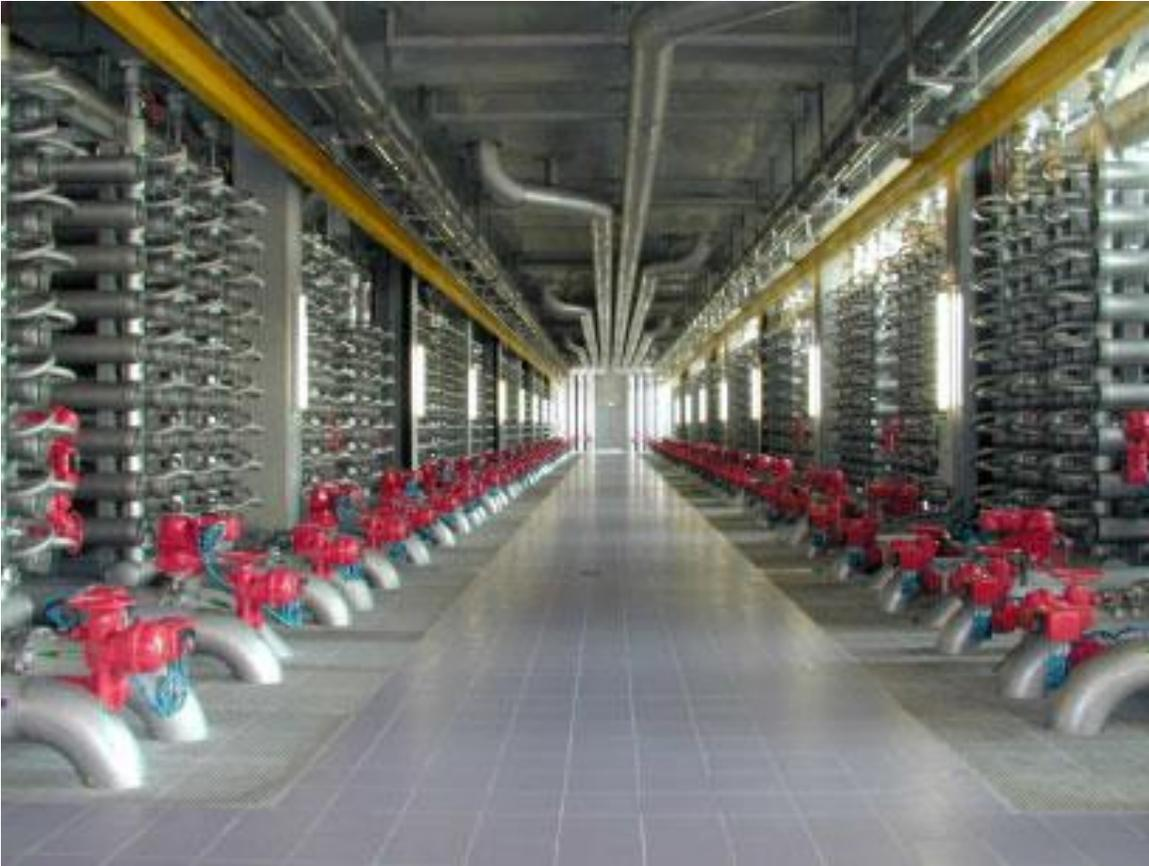
**Figura 21. Membranas de Nanofiltración.**
