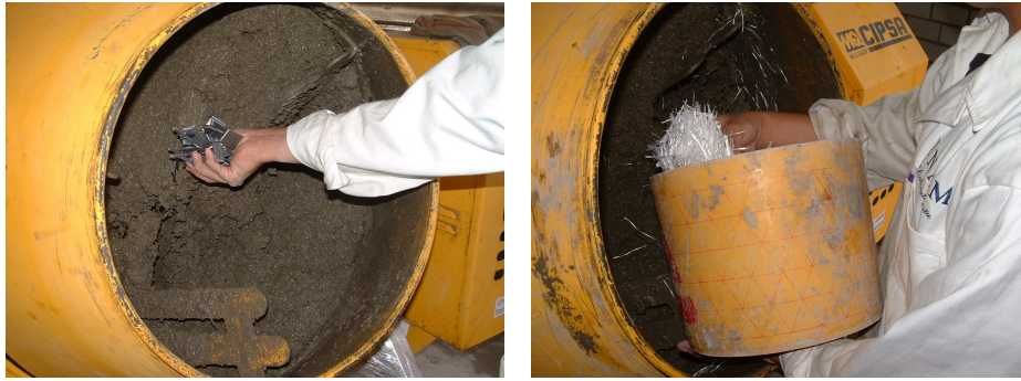
Figura 2.7 Adición de fibras a la revolvedora
