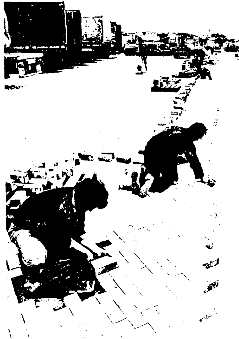
Figura 7. Una superficie extensa de colocación en una terminal de carga y descarga.
