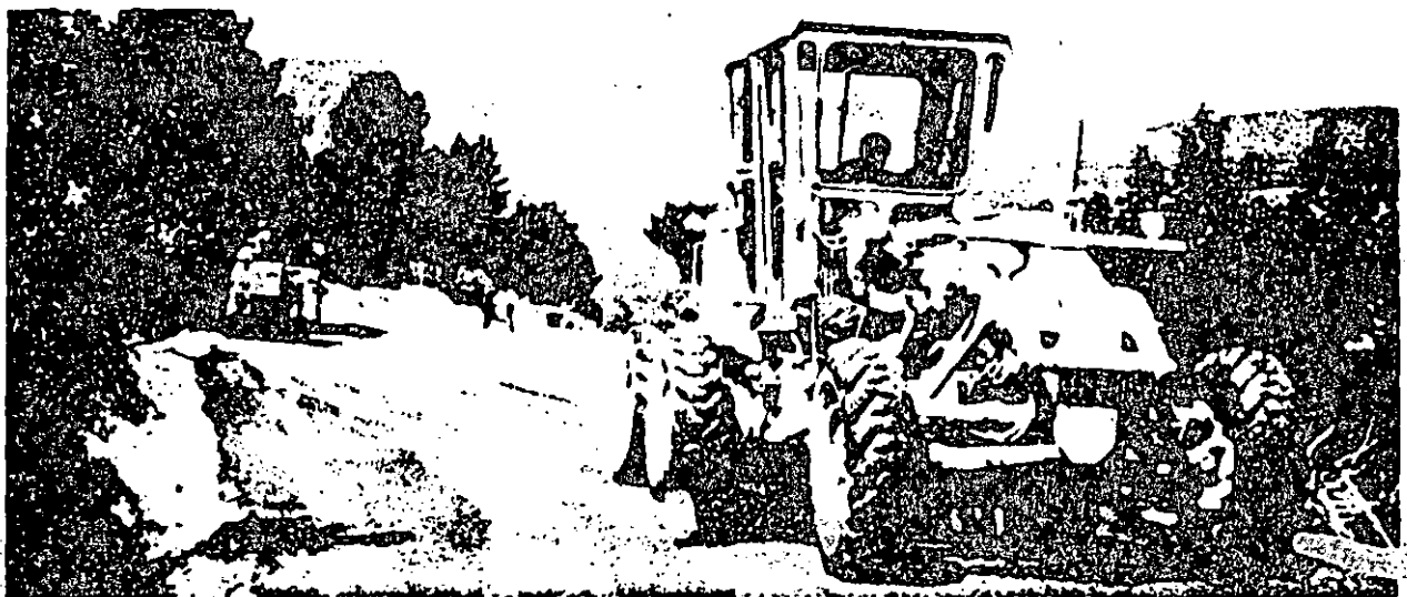
TRABAJOS DE COLOCACION DE BASE NEGRA.
