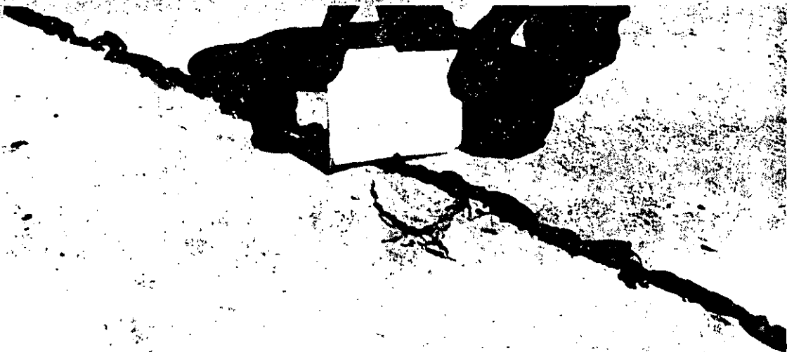
Fig. 1.4-6 Desconchamiento debido a impedimento de movimiento causado por la infiltración de arena en las juntas, las que muestran un sellado defectuoso
