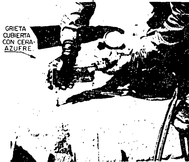
Fig. 1.4-30 Inyectado de adhesivos en la grieta ya preparada
