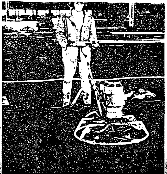
Figura 15.- Aplanado mecánico.
