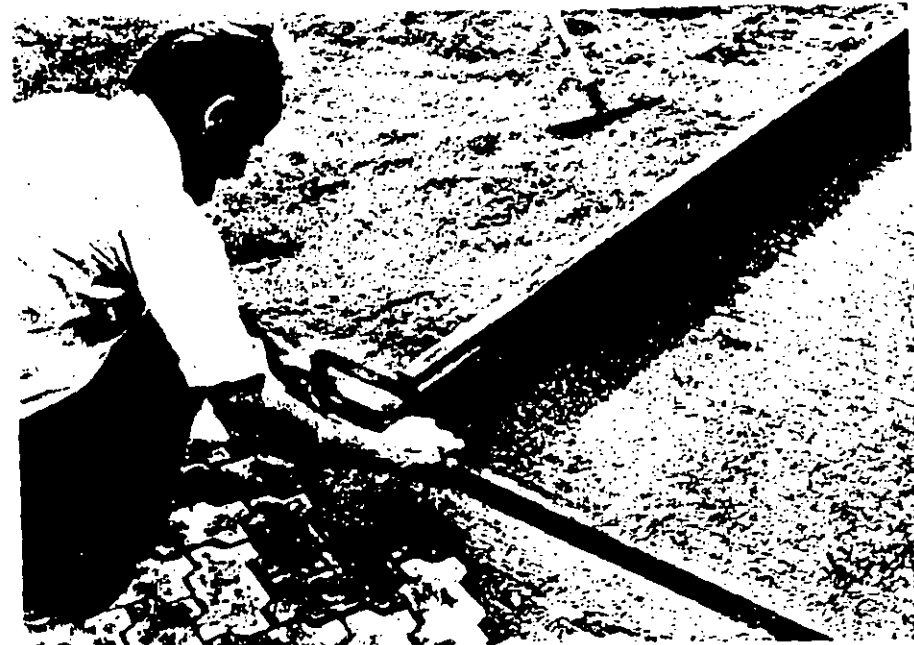
Figura 13. Enrasado entre rieles temporales de enrase.
