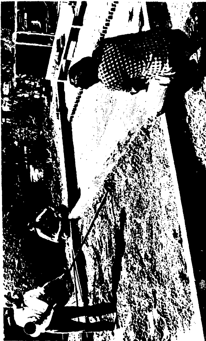
Figura 12. Enrasado entre las guarniciones.
