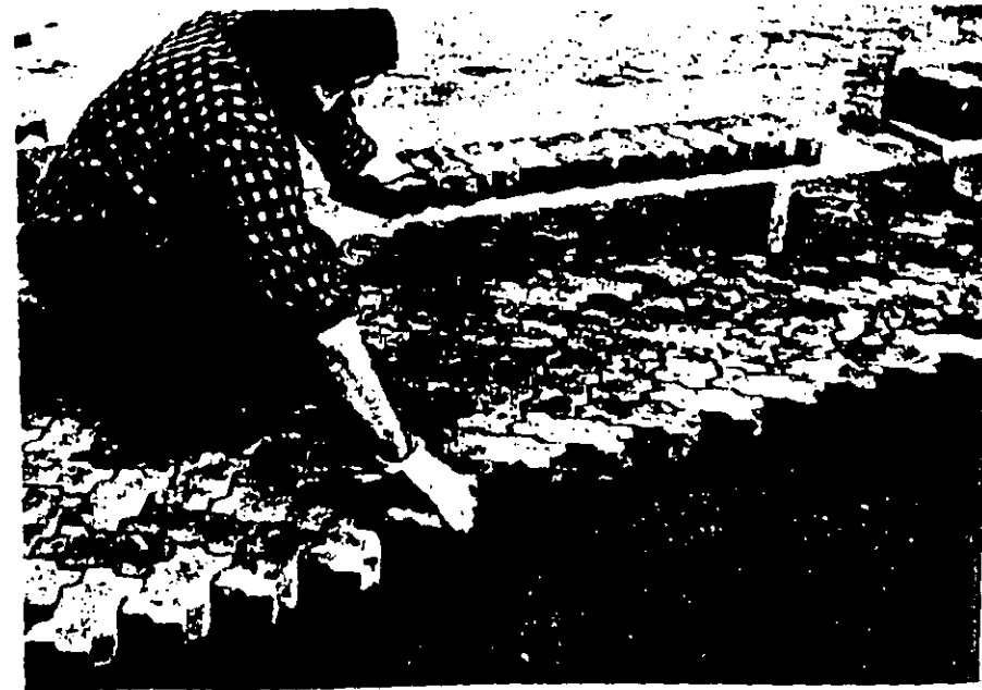
Figura 14. Colocación de los adoquines.
