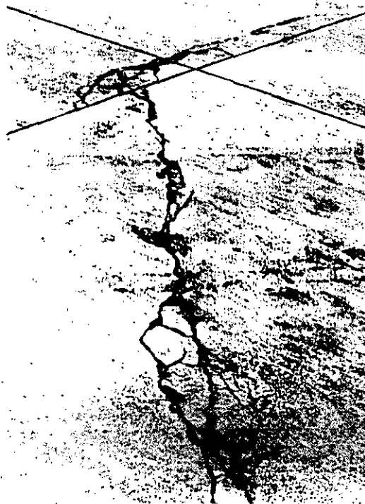
Fig. 1.4-41 Grieta en diagonal y grietas en esquina. Fallo estructural debido probablemente a la falta de apoyo de las losas, subdrenaje defectuoso y o las cargas
