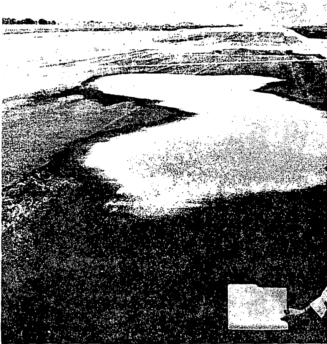
Fig. 2.5-19 Hundimientos diferenciales o depresiones en el pavimento que provocan la formación de charcos cuando llueve, situación indeseable para la operación de los aviones por la posibilidad de que se presente el hidroplaneo
