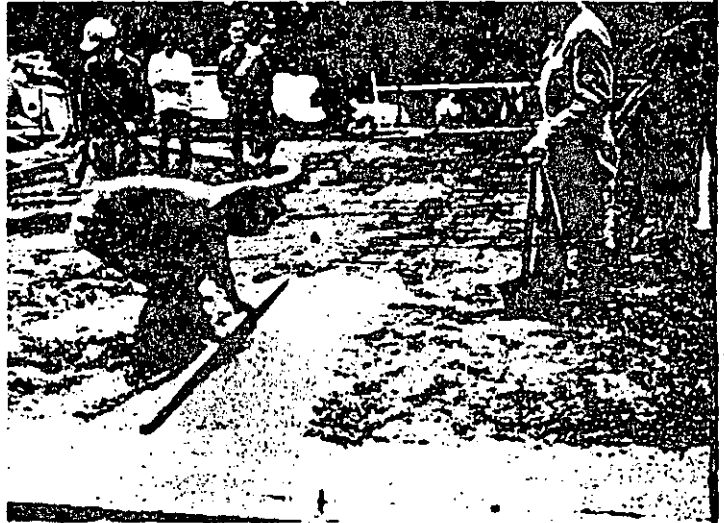
Figura 10.- Los "niveles húmedos" se nivelan entre los puntos de referencia.
