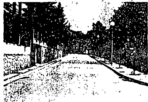
Fig. 2 Pavimento de CCR en zonas urbanas.
