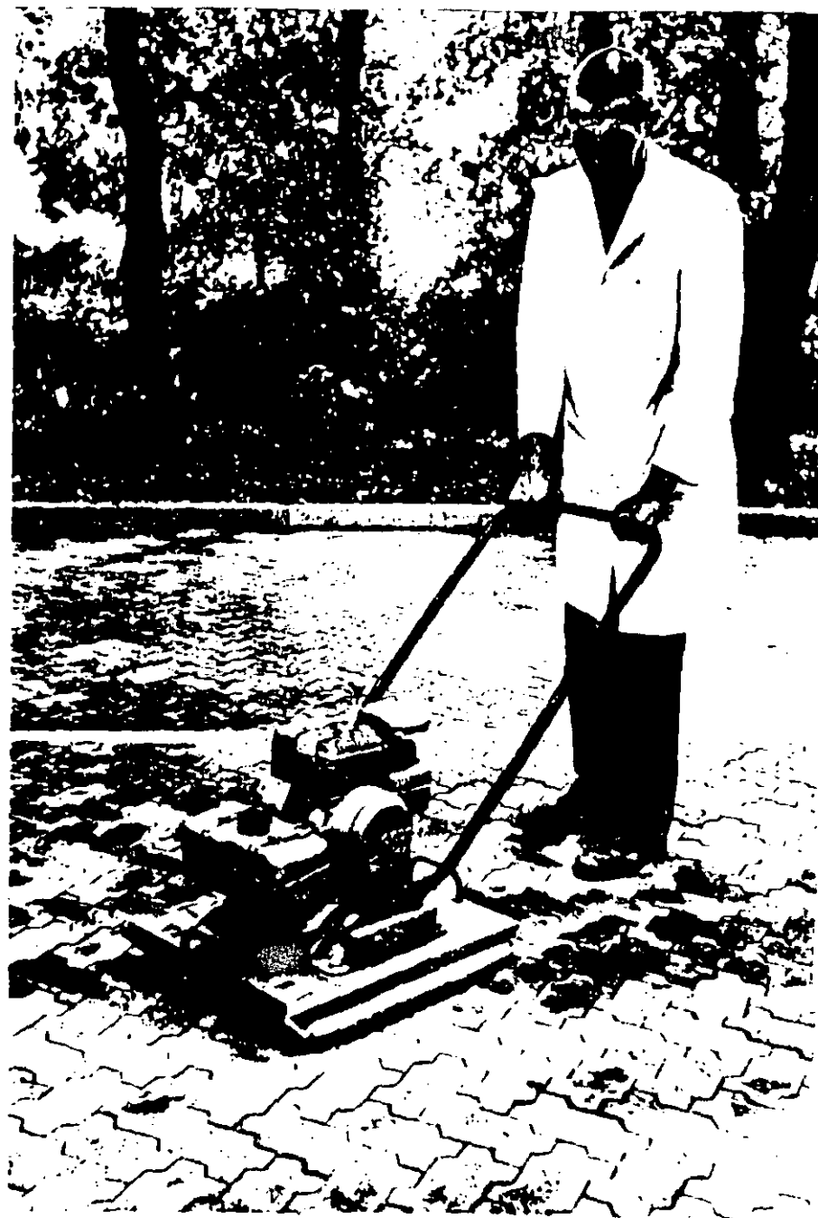
Figura 17. Uso de una placa vibradora para compactar el adoquinado.
