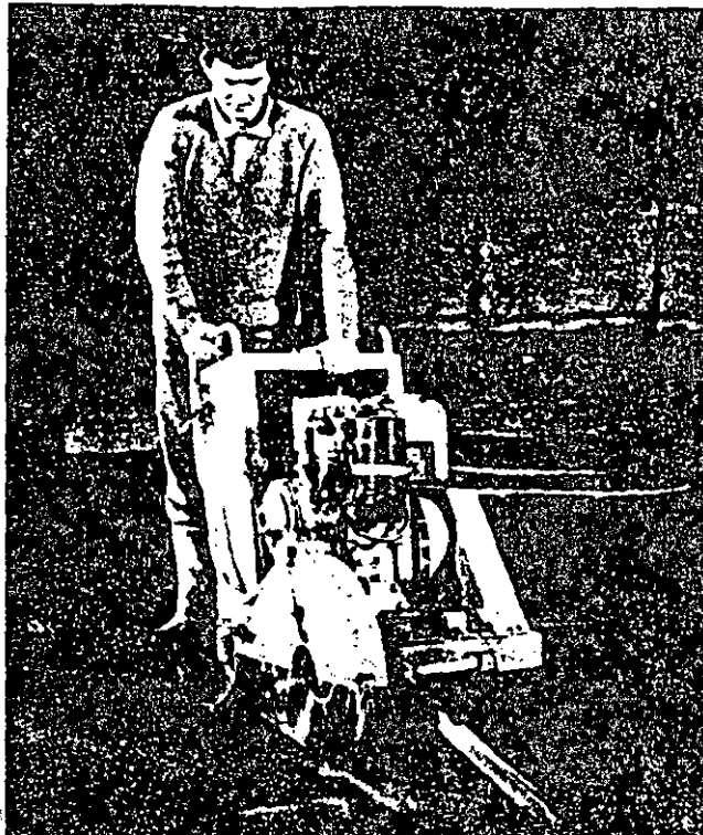
Figura 4.- Formación de una junta de control aserrada.
