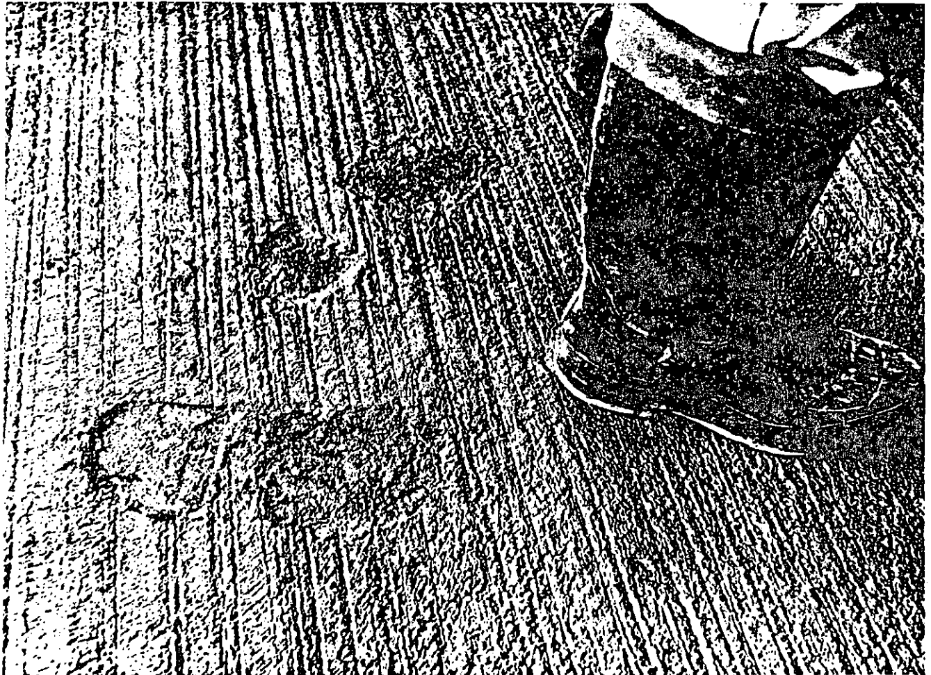
Figura 16.- Prueba de huellas llevada a cabo antes del nivelado y aplanado final.
