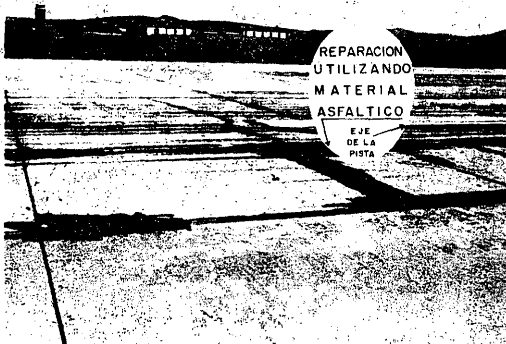
Fig. 1.4-26 Grietas longitudinales y transversales y algunos astillamientos en el tramo central de la pista, ya tratados con material asfáltico. La falta de apoyo de la cimentación, las cargas, efectos de impacto y los efectos de temperatura son las probables causas de la falla
