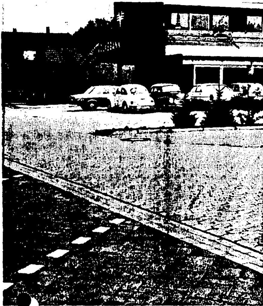
Figura 1. Marcas de los lugares para automóviles en un estacionamiento, formados con adoquines, cuya parte superior está pintada de blanco.
