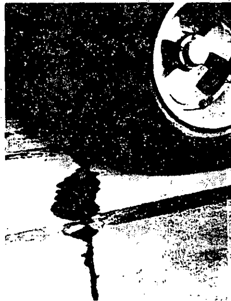
Fig. 1.4-44 Al paso de un "eje doble-doble tandem" es "bombeada" el agua con finos hacia el exterior.
