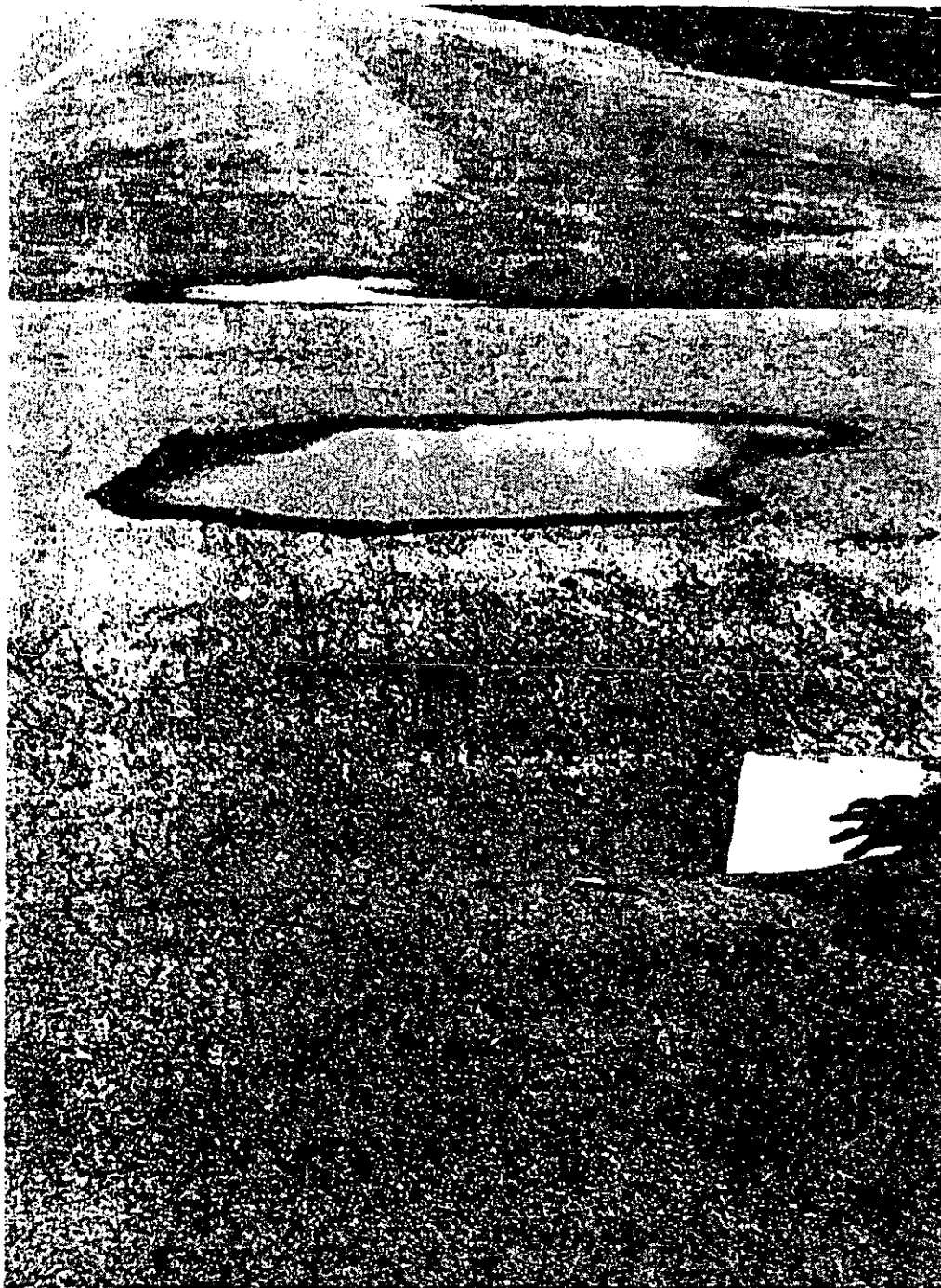
Fig. 2.5 - 20 Depresiones con grietas. Formación de charcos
