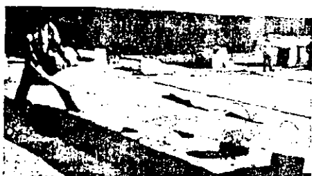
IMPERMEABILIZACION EN CALIENTE A BASE DE FIELTROS
