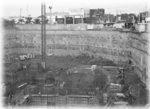
Figura 18. Excavación a nivel de proyecto.
