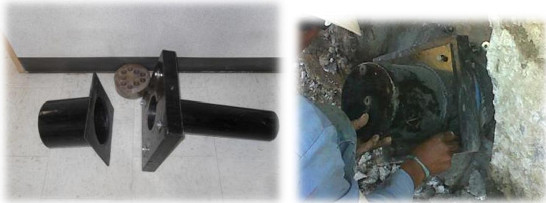
Figuras 85. Capuchón y tubo trompeta empleados en la protección de anclas permanentes.
