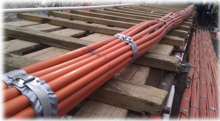
Figura 48. Colocación de flejes a lo largo del cuerpo del ancla.
