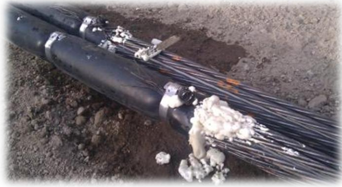
Figura 42. Colocación de espuma selladora para evitar la entrada de lechada a la parte libre del ancla.
