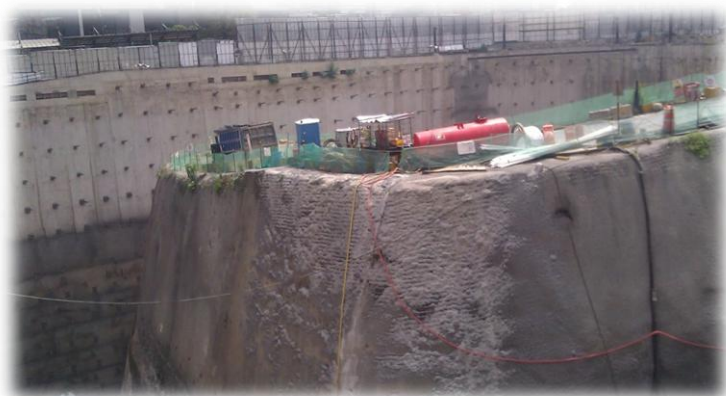
Figura 21. Rampa de acceso a la excavación.
