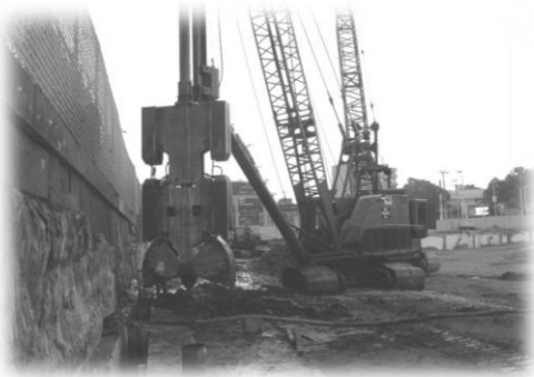
Figura 17. Excavación de zanja con almeja.
