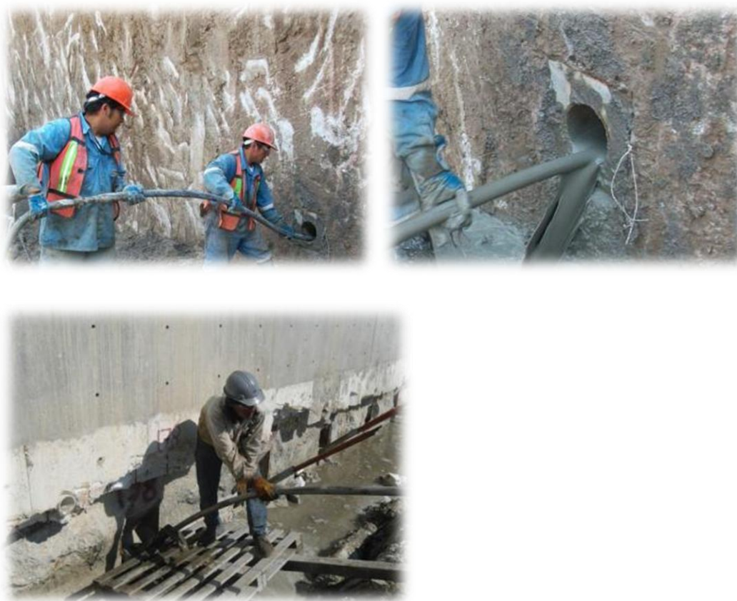
Figuras 58. Para anclas permanentes también es común utilizar este procedimiento de envainado por gravedad.
