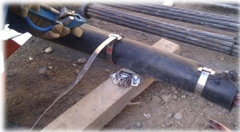
Figura 41. Colocación de flejes.
