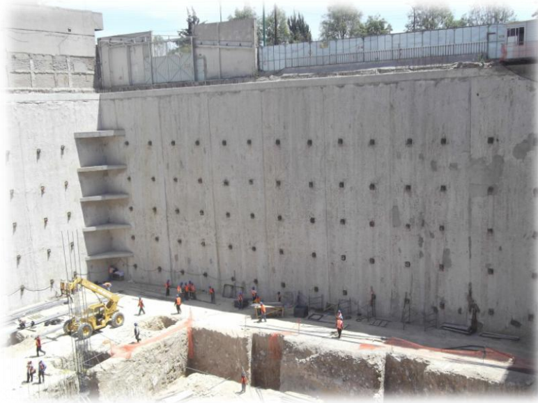
Figura 22. Muro Milán y anclas para una excavación.
