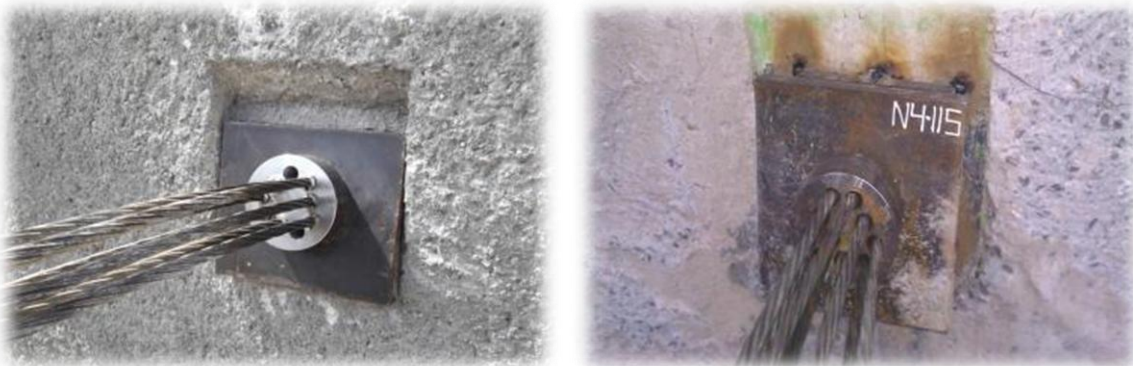
Figura 72. Silletas y quesos ya instalados.
