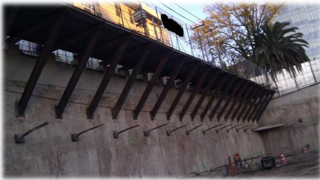
Figura 34. Vista general de la plataforma de trabajo.
