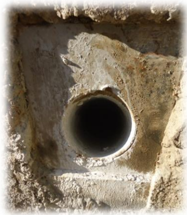
Figura 51. Preparación sobre muro Milán.
