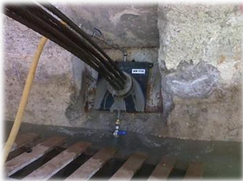
Figura 83. Inyección de lechada.
