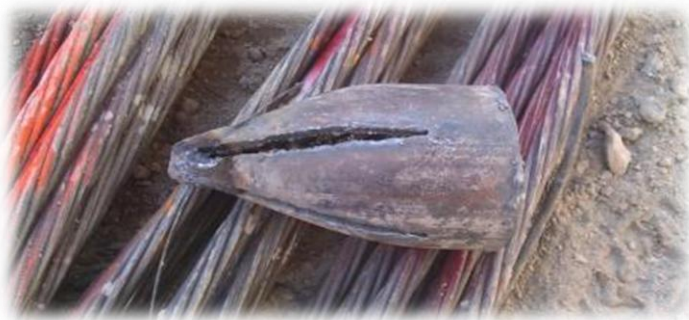
Figura 28. Capuchón fabricado en obra.
