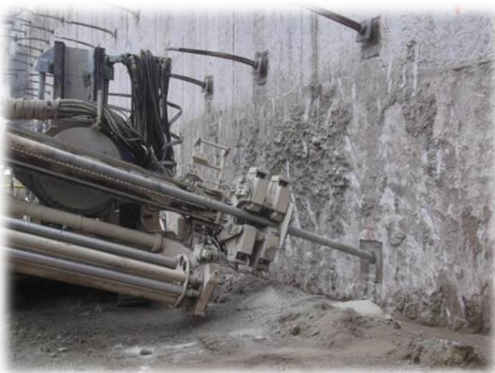
Figura 57. Empleo de barras para dar continuidad a la perforación
