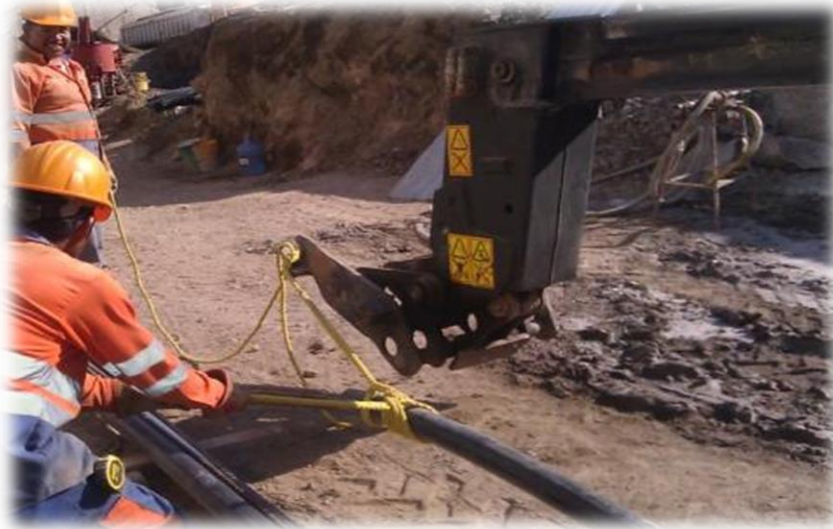
Figura 40. Entrada de tirante armado dentro de poliducto PAD.
