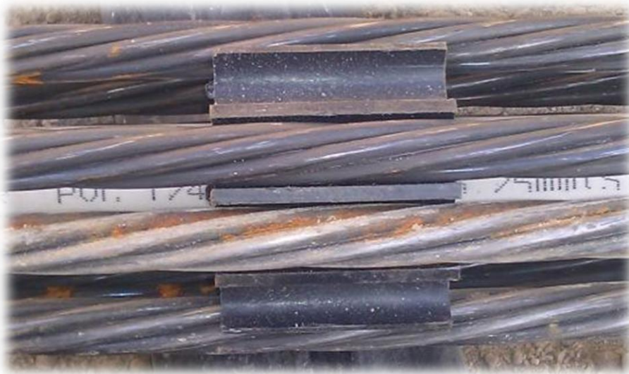
Figura 38. Vista de separador instalado.
