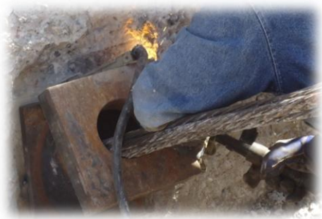
Figuras 70. Colocación y soldado de silleta.
