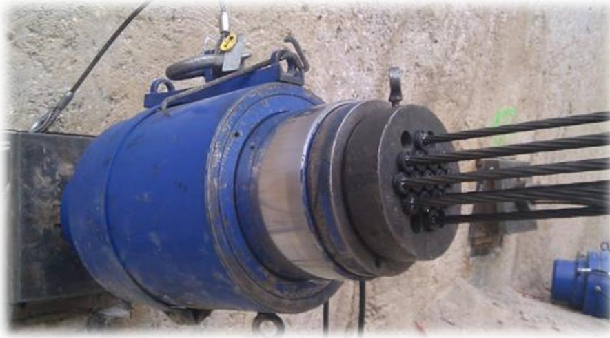
Figura 73. Montaje de gato con capacidad para 15 torones.
