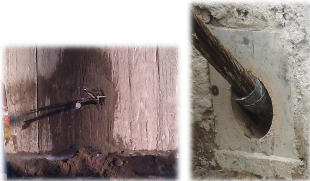
Figuras 60. Ancla dentro del barreno.
