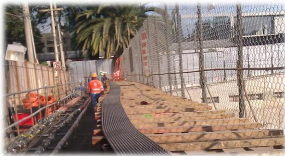
Figura 44. Corte de cable torón en Mesa de trabajo.
