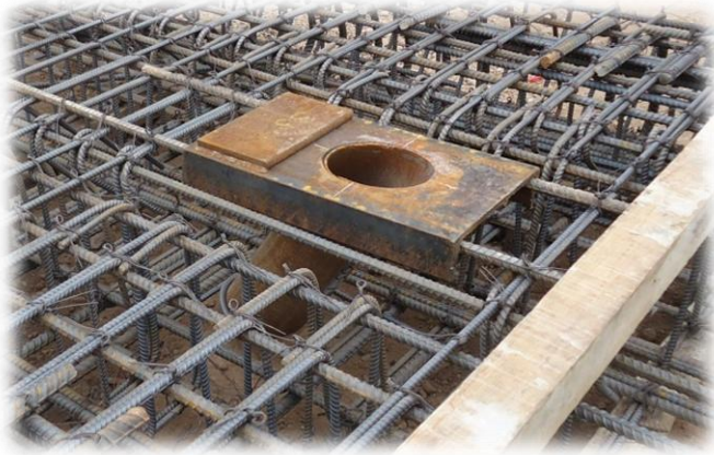
Figura 50. Colocación de preparaciones para la perforación del barreno antes del colado del muro Milán.
