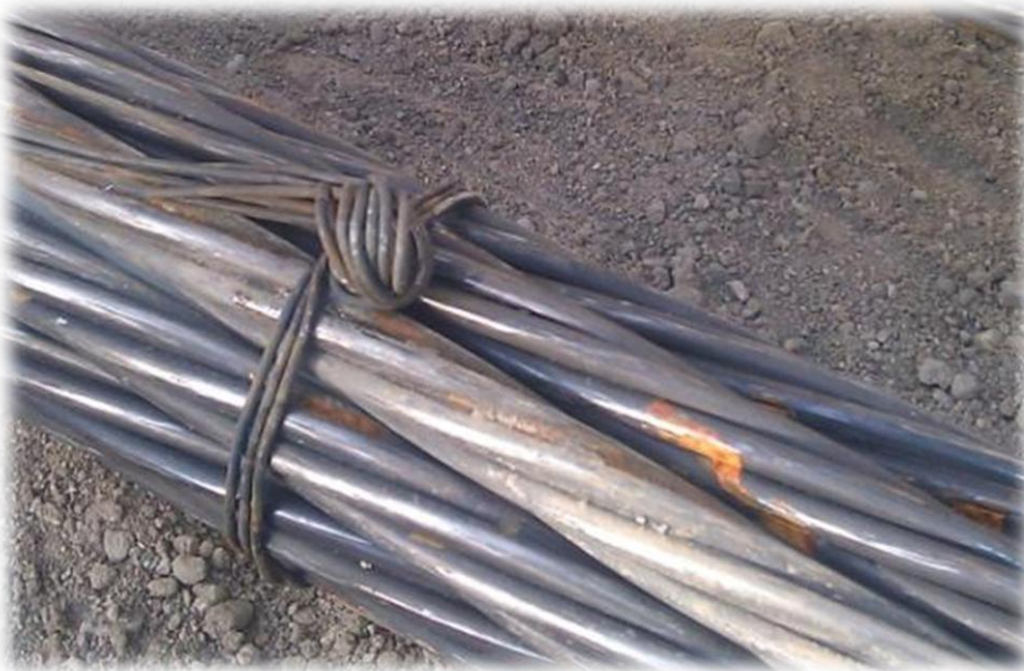
Figura 39. Amarre con alambre recocido.
