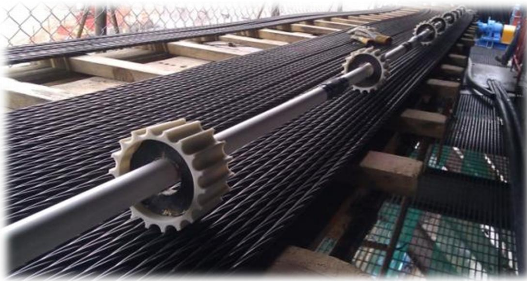
Figura 47. Colocación de separadores de plástico.
