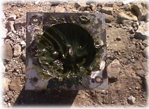
Figura 84. Grasa de litio empleada para proteger la cabeza del anclaje
