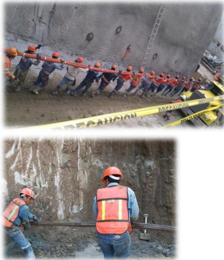
Figuras 59. La carga e introducción del tirante en el barreno para el caso de anclas que posean gran longitud, se lleva a cabo de manera manual.
