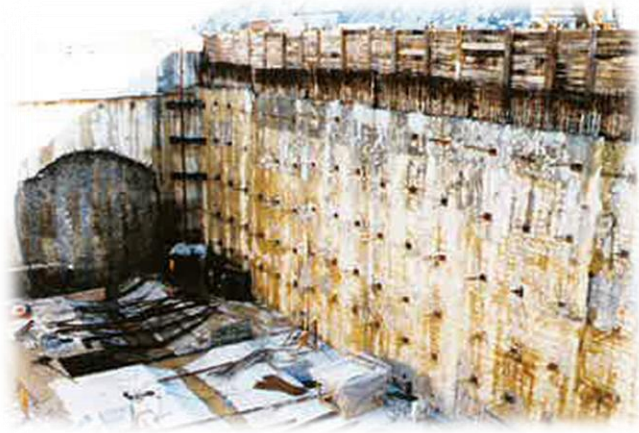
Figura 6. Protección de muros entre estaciones para continuar con tuneleo.
