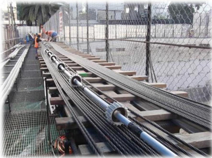
Figura 37. Colocación de separadores de plástico.
