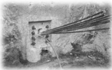
Figura 19. Reservaciones sobre el muro Milán para las anclas postensadas.
