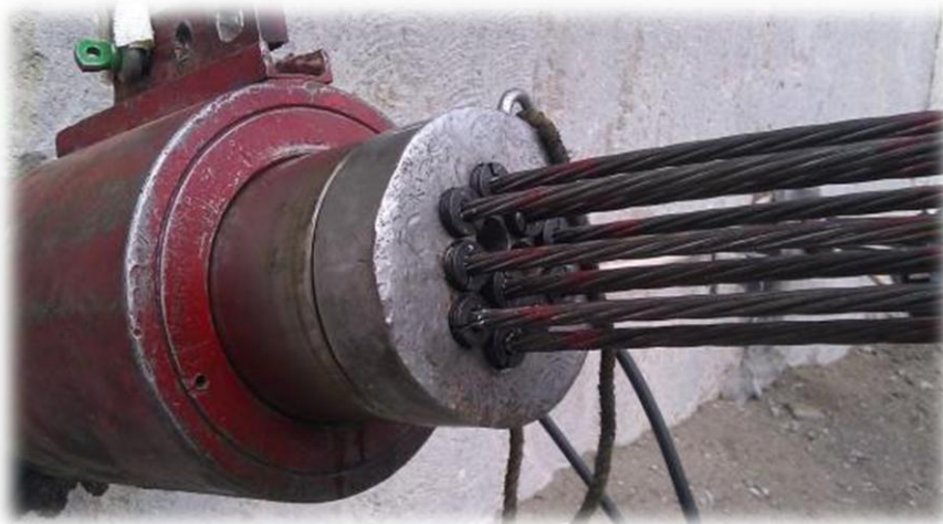
Figura 74. Montaje de gato con capacidad para 10 torones
