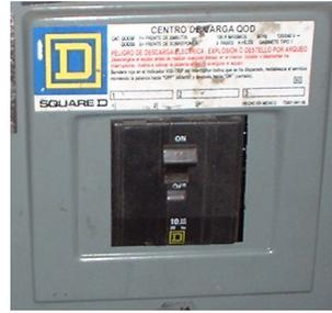
Figura 2.15 interruptor termo magnético de 3polos de Square D con capacidad nominal de 100<sup>a</sup>
