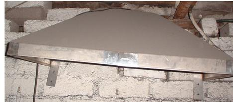
Figura 2.14 Campa para extracción de aire
