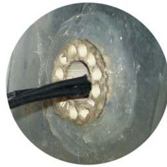
Foto 2. Ensamblajes sellados con silicón.
