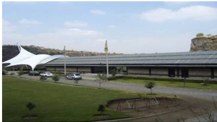
Fotografía 1 Instalaciones del Club Deportivo Universidad Nacional
