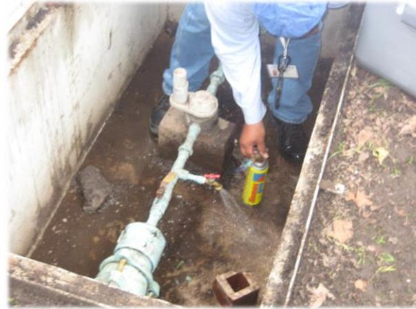
Ilustración 11. Toma de muestras para análisis de calidad del agua en Edificios 2, 3 y 4: Toma de la red principal, ubicada debajo del puente que une a estos edificios. FUENTE: Elaboración propia.
