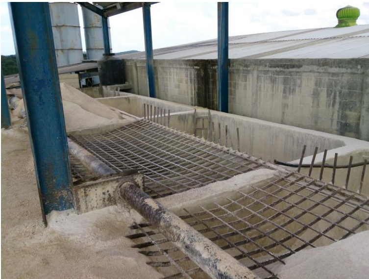
Figura 17. Tolvas de materiales.
