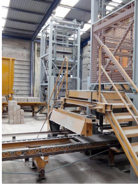
Figura 22. Elevador (derecha) y descenso (izquierda) de blocs y la banda transportadora que los alimenta.
