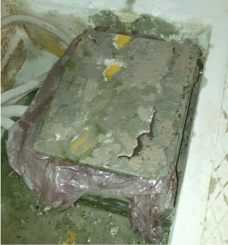
Figura 29. Caja de Conexiones del Paletizador.
