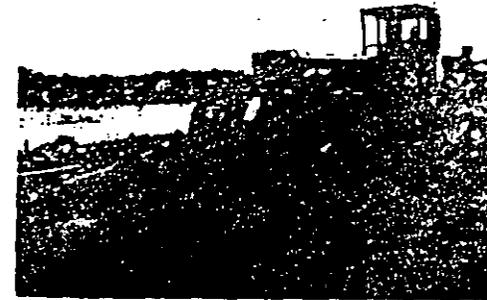
DESPLAZAMIENTO DE MATERIALES.- La hoja de una motoconformadora se puede utilizar para construir terraplenes de forma y emplazamiento determinados, dispuestos paralelamente a la línea de excavación. Para ello, se inclina la hoja un cierto ángulo con respecto a la horizontal, de tal forma, que excava-
