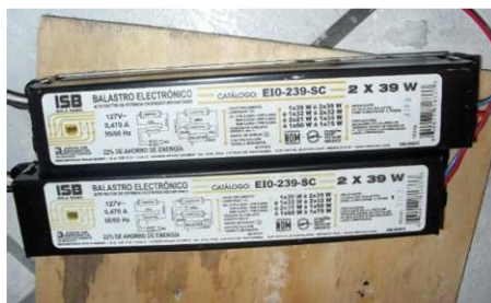
Figura 1-17 Balastos utilizados en caso base
