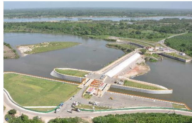
Figura 6 Estructura de control sobre el río Carrizal.
