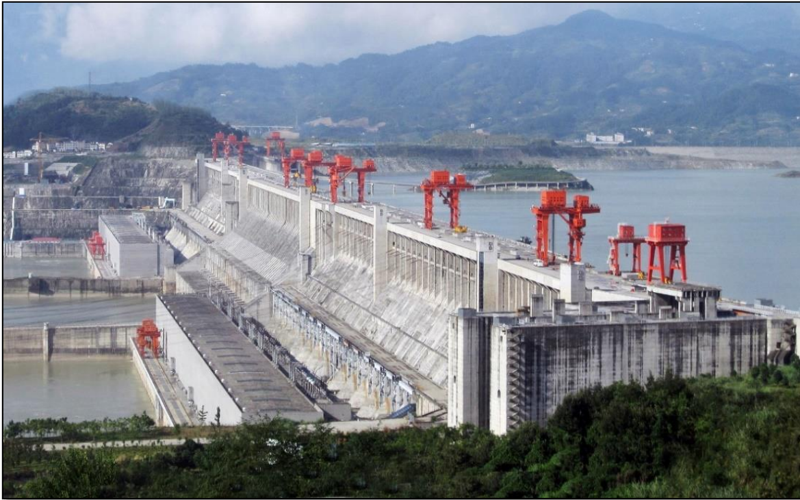
FIGURA 1.2. PRESA TRES GARGANTAS, CHINA
