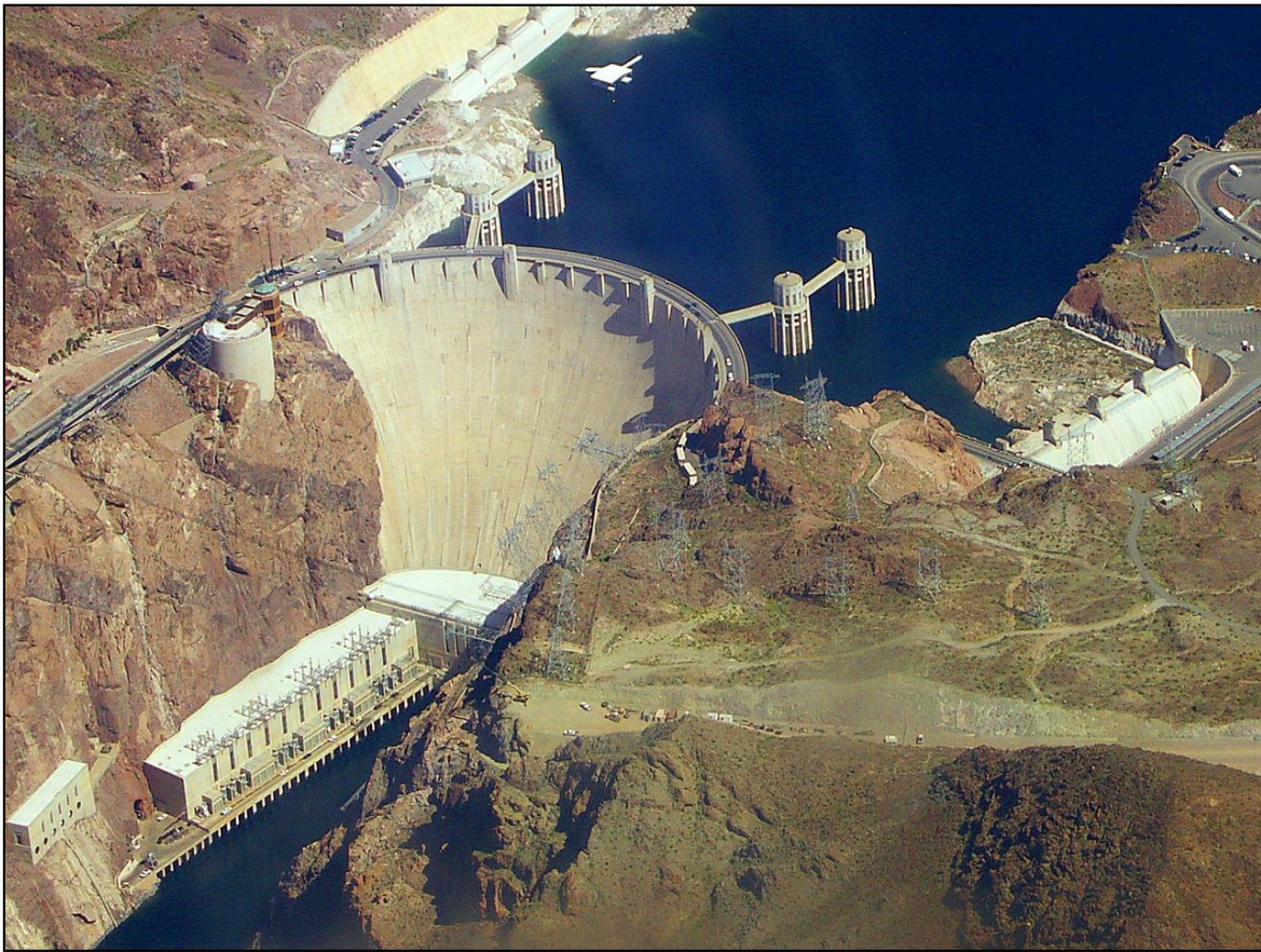
FIGURA 1.8. PRESA HOOVER, TIPO ARCO-BOVEDA, ENTRE LOS ESTADOS DE ARIZONA Y NEVADA
