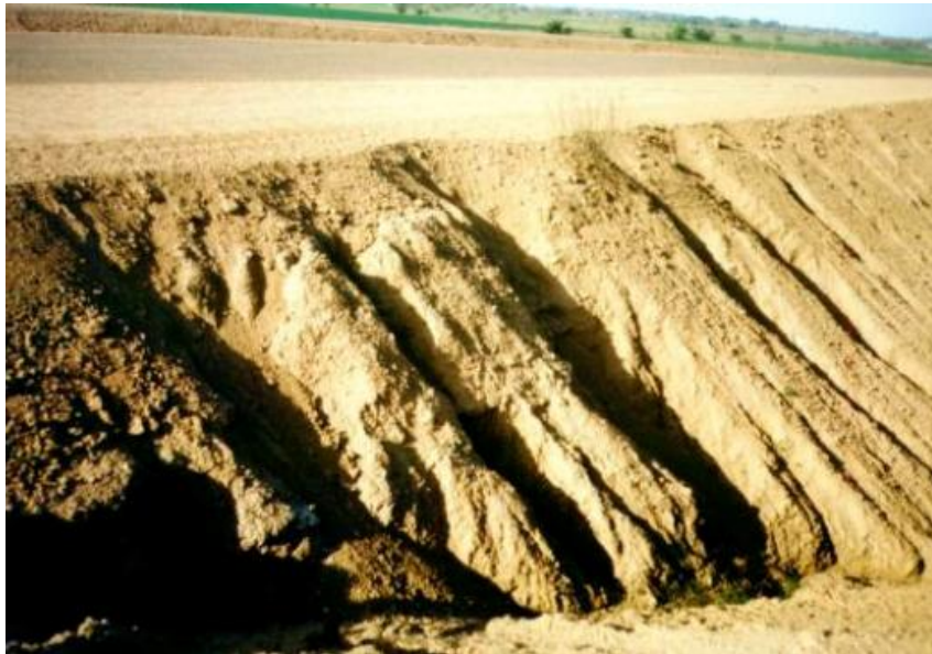
Figura 2.1: Vista del talud que forma parte de un terraplén.
