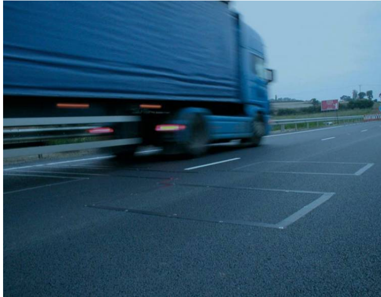
Figura 9. Instalación en una carretera.
