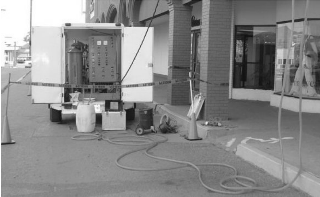
Figura 14. Foto de filtradora trabajando.
