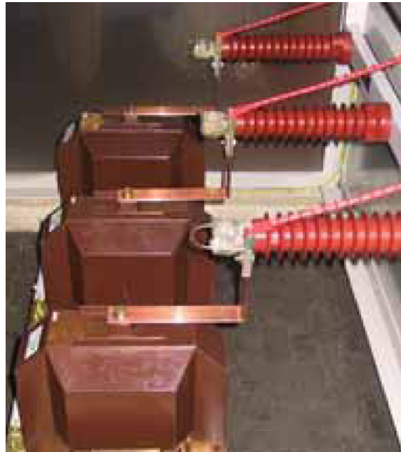
Figura 30. Transformadores de potencial para sistemas de MT.
