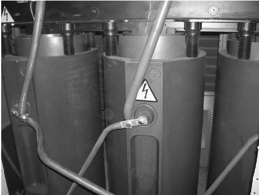
Figura 10. Foto de los devanados MT en resina epóxica.
