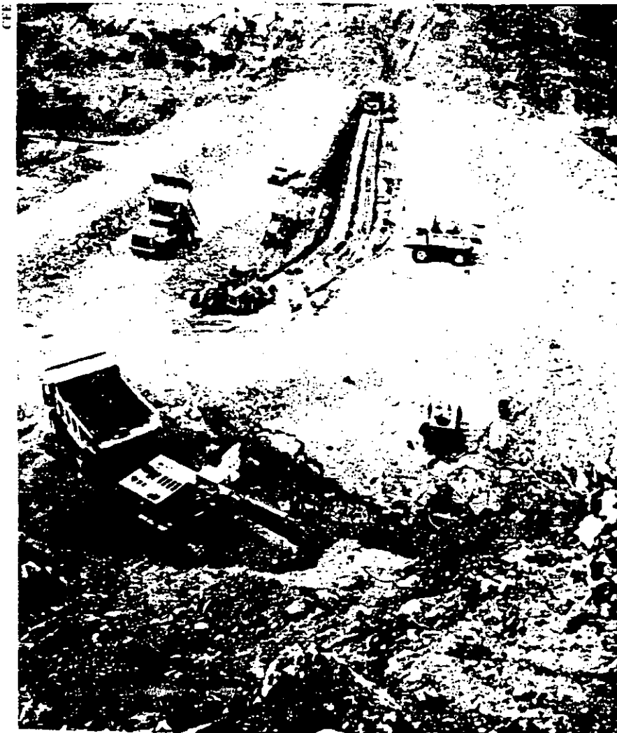
Construcción de la ataguía.
