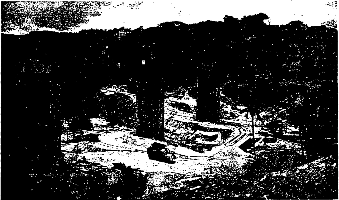
Puente El Ejido. Tramo Tierra Colorada-Acapulco.
