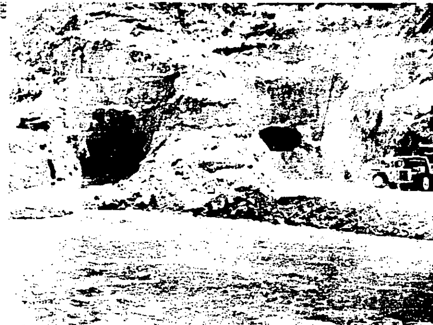
Salida de los túneles de desvío.
