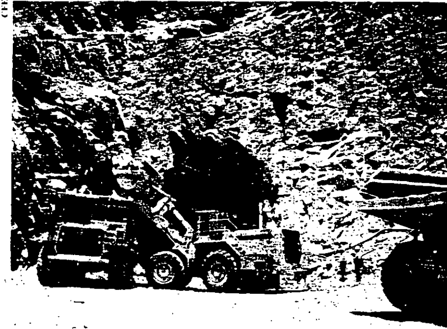
Excavación del portal de los túneles de desvío.
