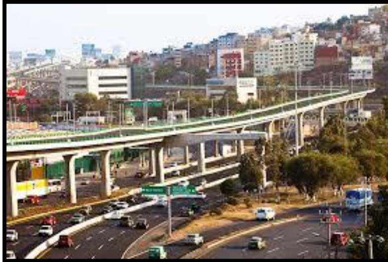
Figura 2.12 Viaducto Bicentenario, México
