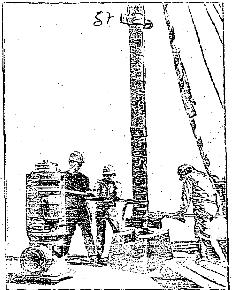
ILUSTRACION No. 4. Enroscando el juego de razones al tubo de succión.
