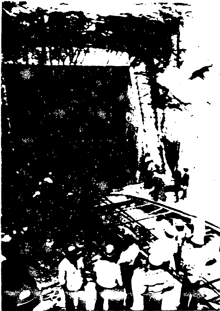
INTRODUCCION DE UNA SECCION DE LA TUBERIA DE PRESION DENTRO DEL TUNEL.
