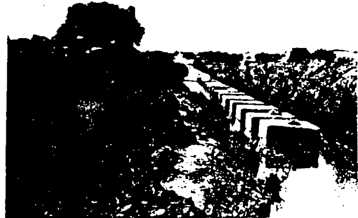
XXX.- Contrapesos superpuestos a la tubería ya alojada en la zanja.
