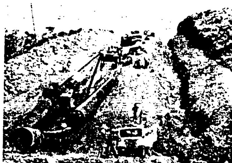
FIG. XXII.= Doblado de tubería y colocación por medio de Tractor Pluma
