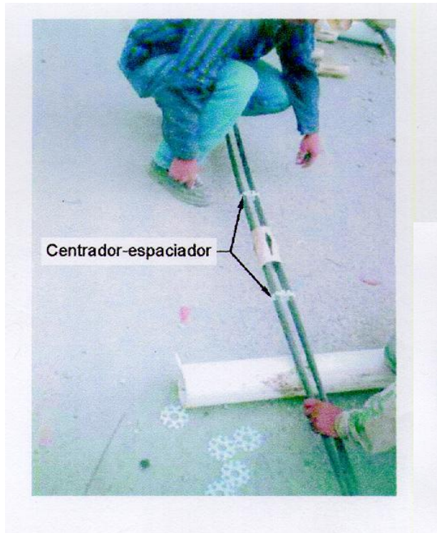
Figura 1.9 Colocación de centradores y espaciadores.
