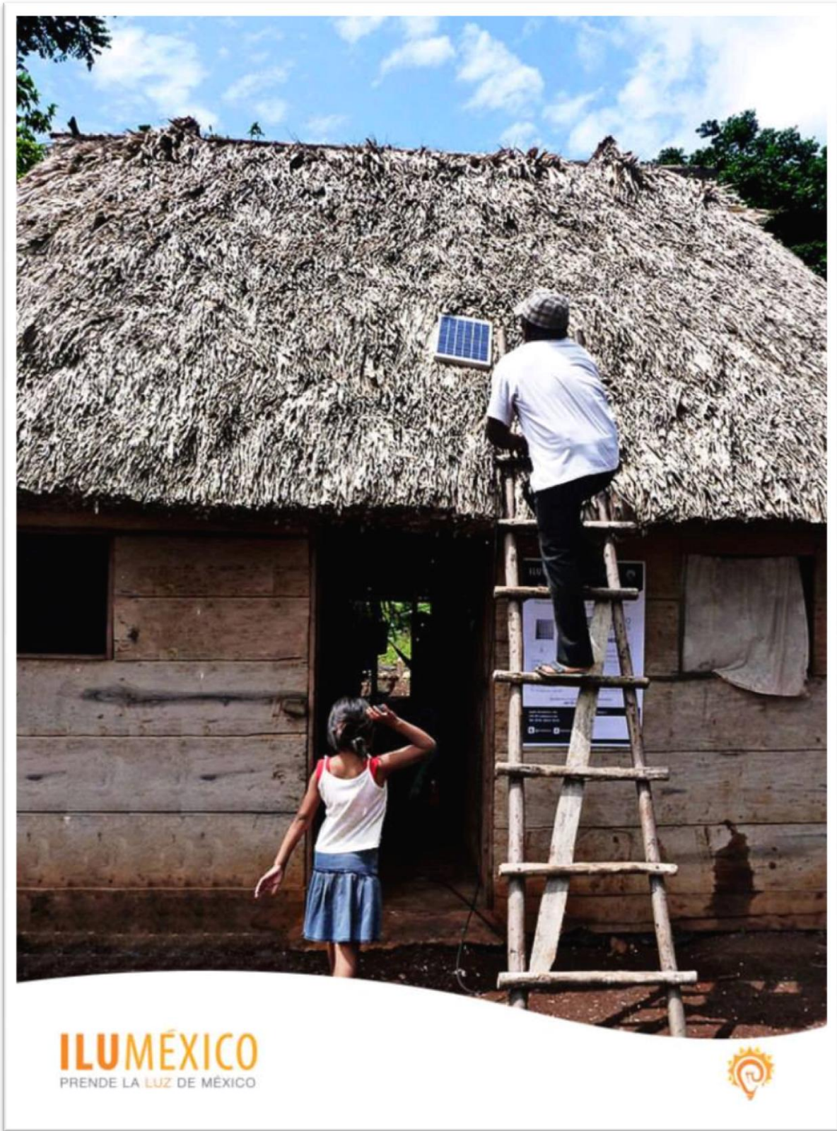
Figura 4.7 Instalación del equipo fotovoltaico (Illuméxico, 2012).
