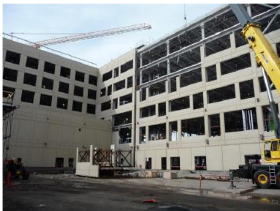
Figura 2.1 Instalación de paneles prefabricados de concreto en un sistema estructural (Hutchinson et al., 2014).
