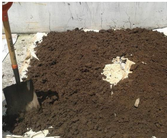
Figura 30. Secado de los residuos de excavación
