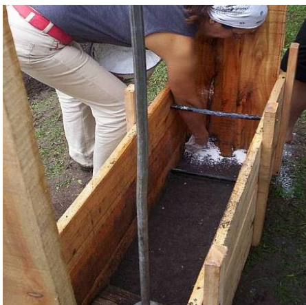
Figura 22. Construcción de tapial para cimiento de una vivienda
