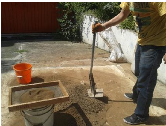
Figura 31. Apisonado de los residuos de excavación
