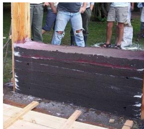
Figura 22. Construcción de tapial para cimiento de una vivienda
