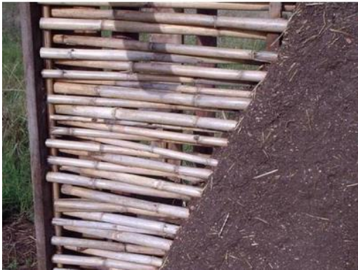
Figura 23. Construcción de vivienda bahareque
