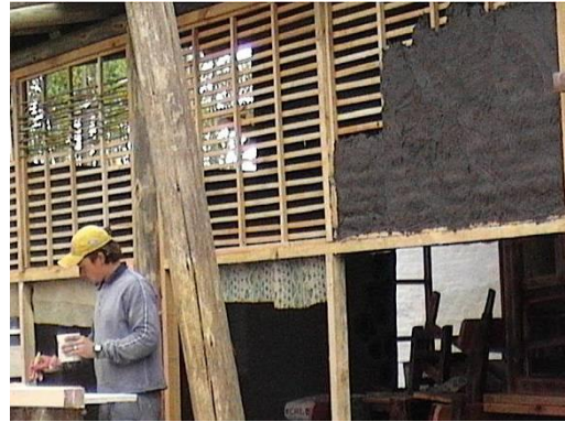
Figura 23. Construcción de vivienda bahareque
