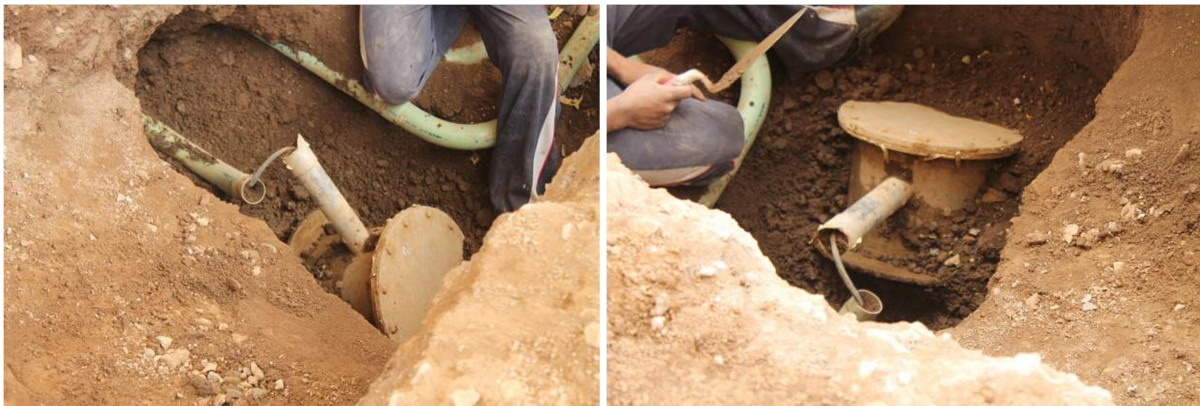
Fig 5.31 Detalle del contenedor de los sensores de aceleración arrancado de la zapata de la columna C5
