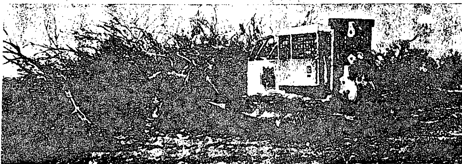
TRACTOR AMONTONANDO LA MALEZA PRODUCTO DEL DESMONTE.
