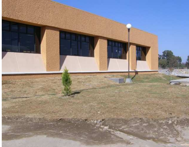
CIBA, fachada noroeste
