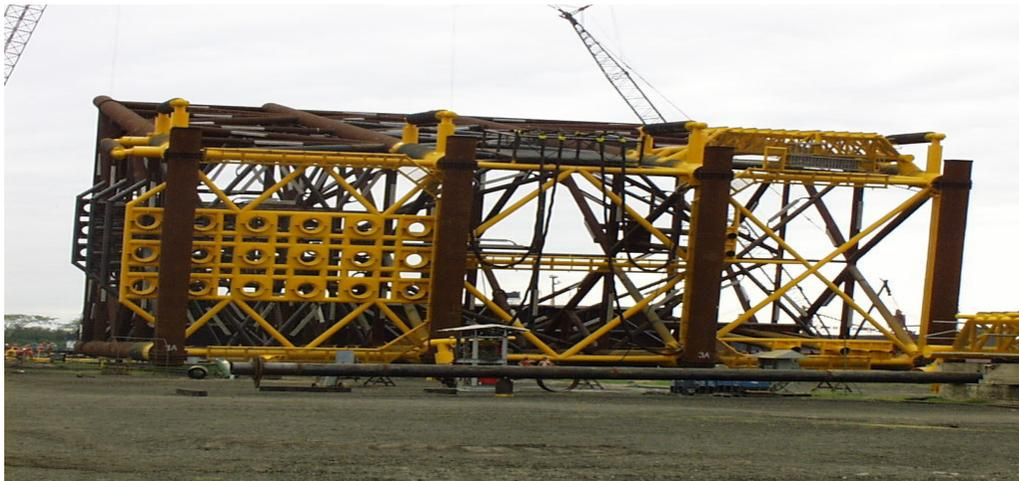
Fig. A10. Fabricación de estructura en patios.
