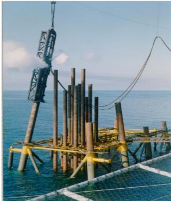
Fig. A12. Instalación de pilotes y conductores.
