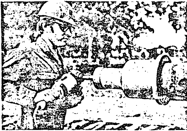
Fig. 7 - Para reparar pequeños defectos de los rebordes, en el sitio de obra se pueden usar herramientas refrentadoras.
