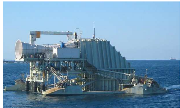
(c) Prototipo de una OWC construida en Port Kembla en New South Wales, Australia.
