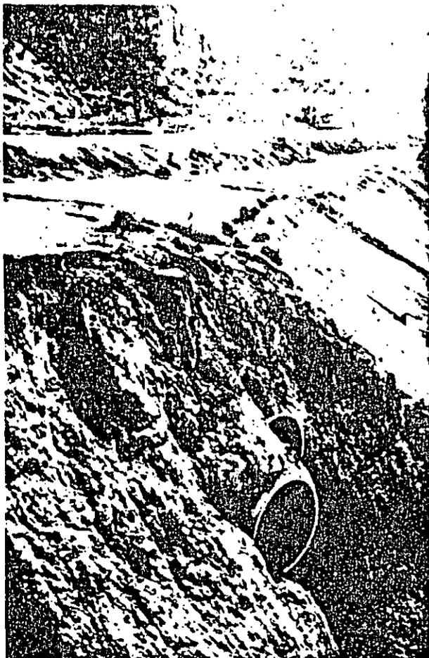
Erosión por infiltración en una alcantarilla mal colocada en el cuerpo de la terracería.
